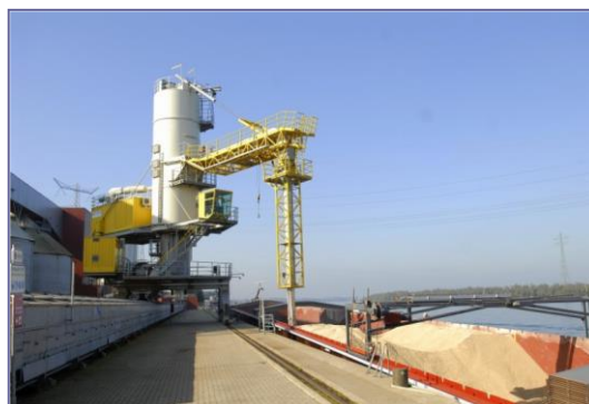
Slika 7. Istovar drvnih peleta na keju sa barže prilikom isporuke elektrani ( http://www.smartplanet.com/blog/the-energy-futurist/the-missing-link-to-a-7-billion-market/ )
