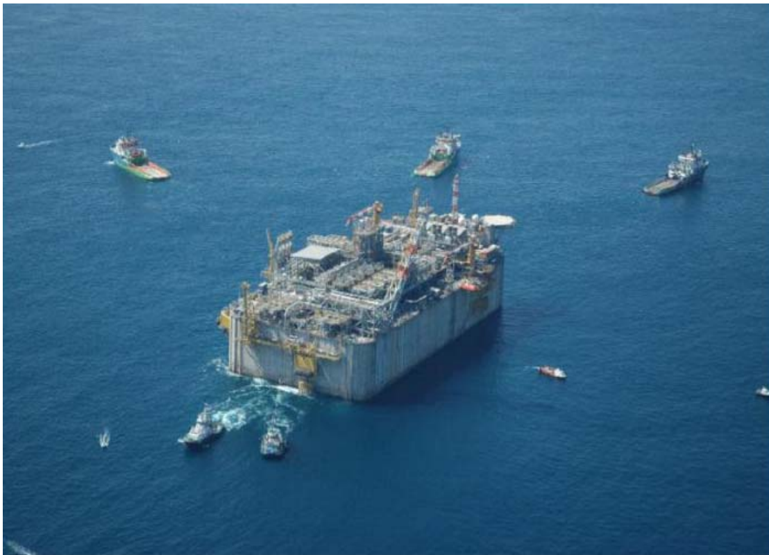
Slika 8.11 Momenat Isplovljavanja GBS-a (preuzeto iz (Mancini i Locatelli, 2012))
