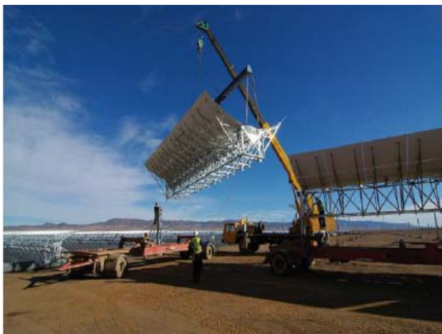
Slika 8.12 Postavljanje panela i izgled solarnog polja (preuzeto iz (Mancini i Localtelli, 2012))
