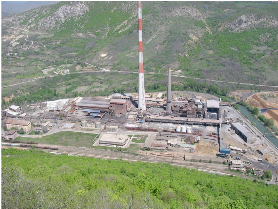
Слика (2): Трепча Рударско-металуршко хемијски комплекс
