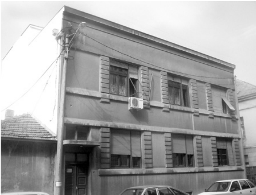
Сл.6.19. Уоквиривање прозорских отвора и обрада зидних платана између прозора
