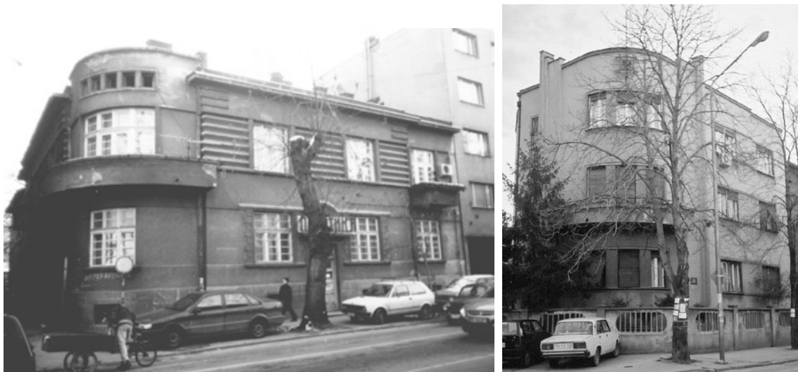
Сл.6.4. Решавање споја фасада на углу праћењем радијуса раскрснице
