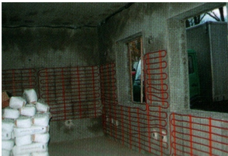
Slika 183. Zidni paneli u fazi montaže ( www.sm-inzenjering.rs )
