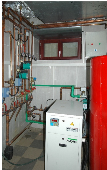
Slika 272. Izgled toplotne pumpe i podstanice (iz Milenić, 2009)
