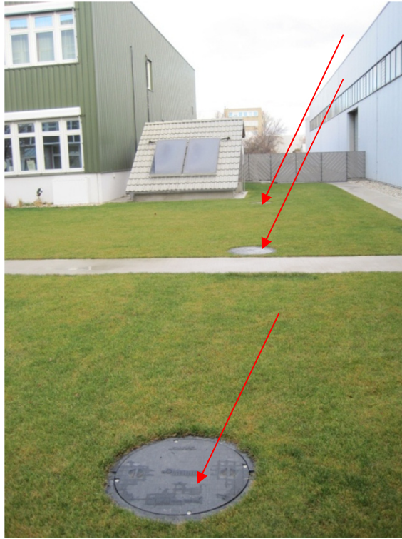
Slika 213. Geosonde (foto: A. Vranješ)
