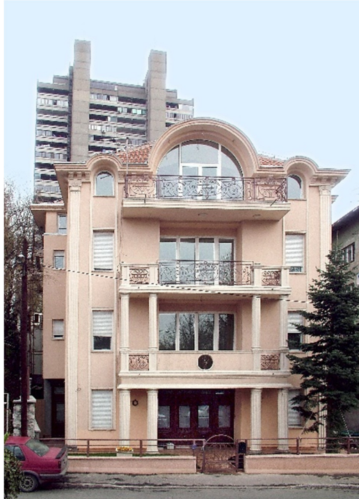
Slika 271. Klinika u Beogradu koja koristi toplotnu pumpu voda-voda za grejanje (iz Milenić, 2009)
