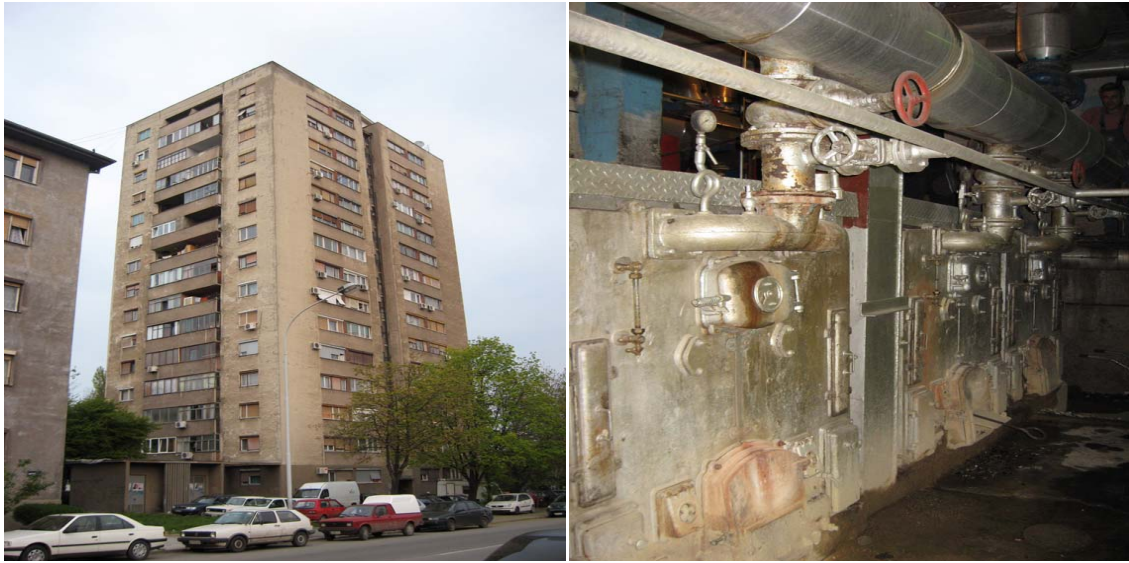
Слика 86. Зграда у којој се налази котларница Миријевски булевар 2 и котлови
