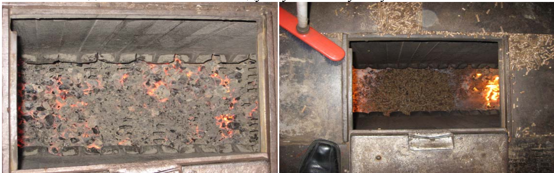
Слика 88. Формирање подлога од жара (угаљ) и ложиште котла након допуне пелетом
