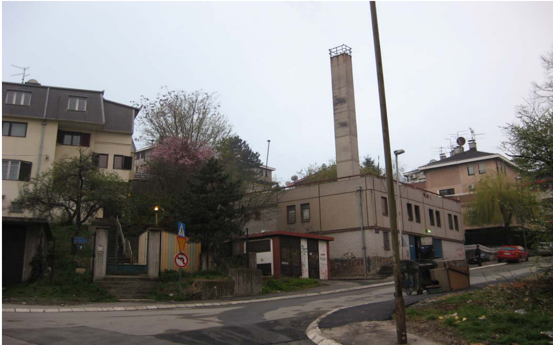
Слика 76. Котларница ”Сењак”
