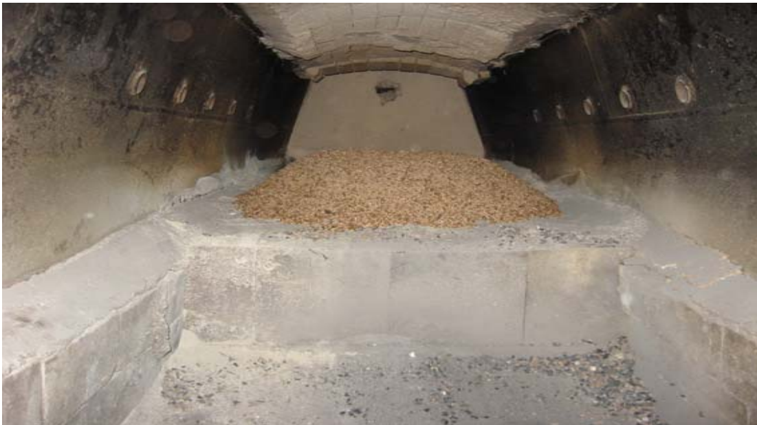
Слика 29. Пелет у ложишту котла приликом одређивања потрошње
