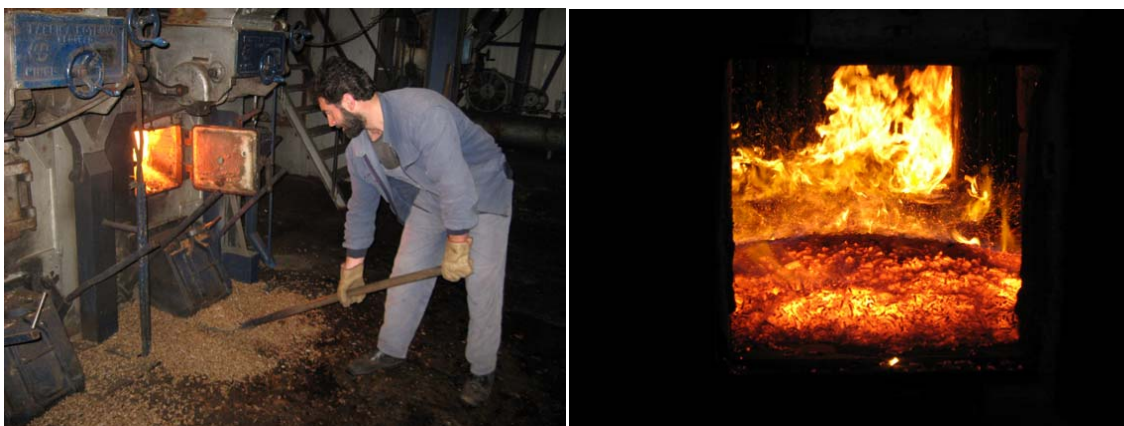
Слика 70. Ручно додавање пелета у ложиште након пропада услед интервенције на додавачу (лево) и сагоревање пелета у ложишту (десно)
