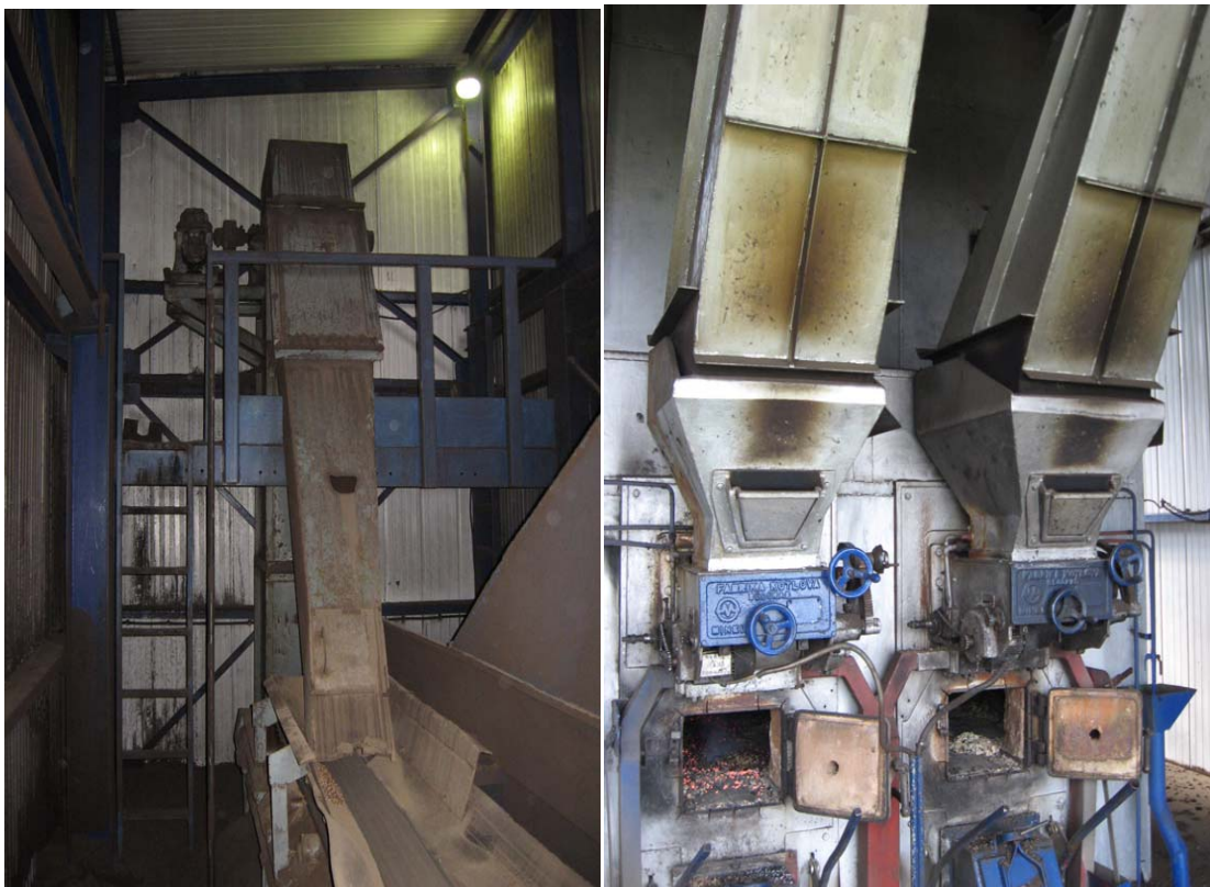
Слика 67. Део транспортног система - елеватора и тракасти транспортер (лево) и уређај за додавање горива у ложиште (десно)
