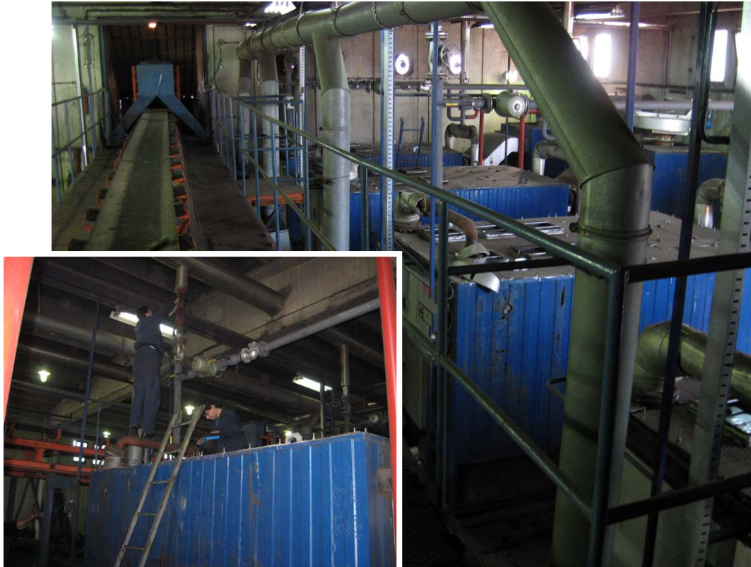
Слика 30. Постављање опреме за мерење протока и диспозиција котлова, тракастог транспортера друге опреме у топлани ”Барајево” - први дана мерења
