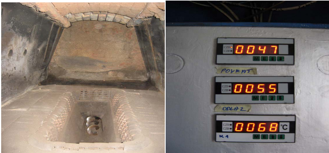
Слика 80. Ложиште котла ВК1 и табла са инструментима
