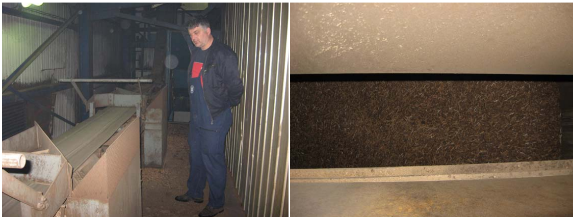
Слика 68. Тракасти транспортер (лево) и пелет у бункеру котла (десно)
