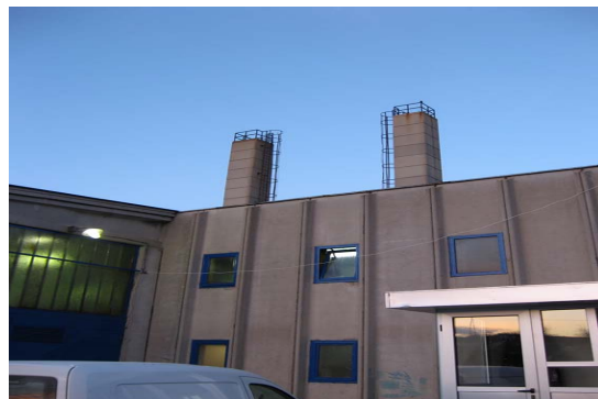
Слика 28. Визуелна контрола димњака за време рада са пелетом
