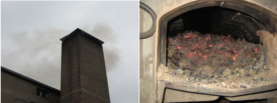
Слика 85. Изглед димњака приликом сагоревања угља и ложиште са угљем
