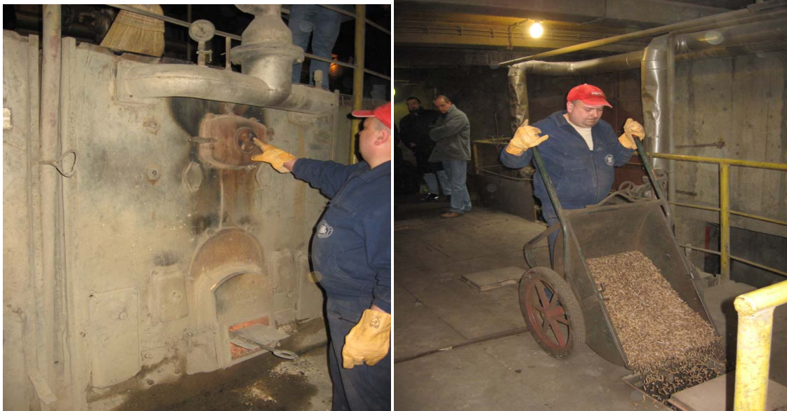
Слика 87. Подешавање количине ваздуха у ложишту и пуњење котла пелетом
