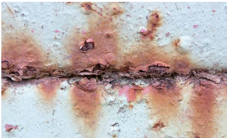
Slika 45 - Korozija pukotina
