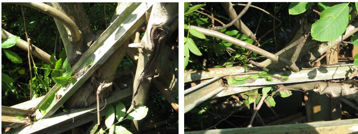
Slika 35 - Prodor vegetacije kroz šupljinu glavnog nosača mosta preko reke Mlave na putu za manastir Rukumija
