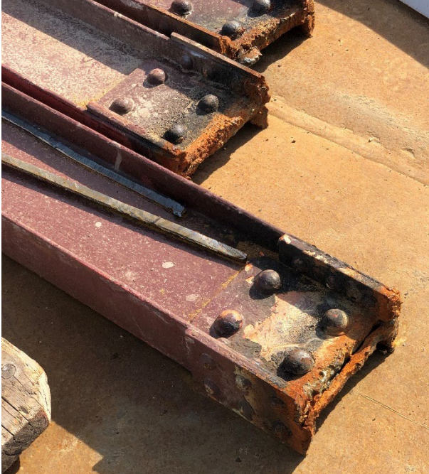
Slika 47 - Naponska korozija na poprečnim nosačima mosta preko reke Nišave ispred niške tvrđave
