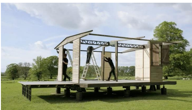
Сл. 69 Ричард Роџерс ( Rogers Stirk Harbor+Partners ): монтажа адаптиране демонтажне куће 6×6 Жана Прувеа из 1944; DesignMiami , Базел, Швајцарска 2015.
