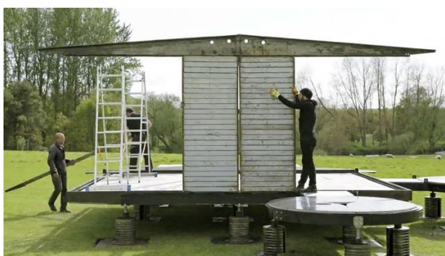
Сл. 68 Ричард Роџерс ( Rogers Stirk Harbor+Partners ): монтажа адаптиране демонтажне куће 6×6 Жана Прувеа из 1944; DesignMiami , Базел, Швајцарска 2015.
