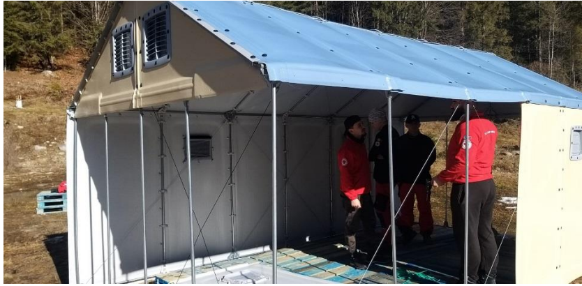
Сл. 37 Better Shelter – Relief Housing Unit (RHU) , постављање RHU јединице за потребе збрињавања украјинских избеглица у Румунији
