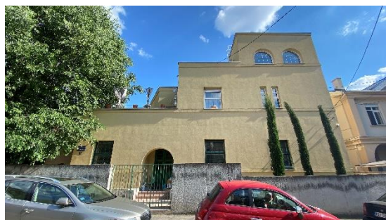
Сл. 145 – Кућа Злоковића, главна фасада из улице Интернационалних бригада
