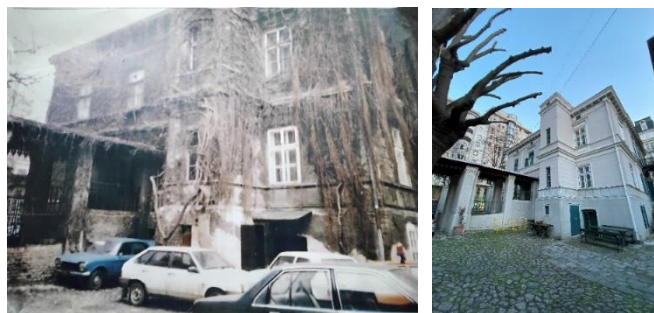
Сл. 136 и 137 – Кућа Вељковић, дворишна фасада (1995 / 2021)
