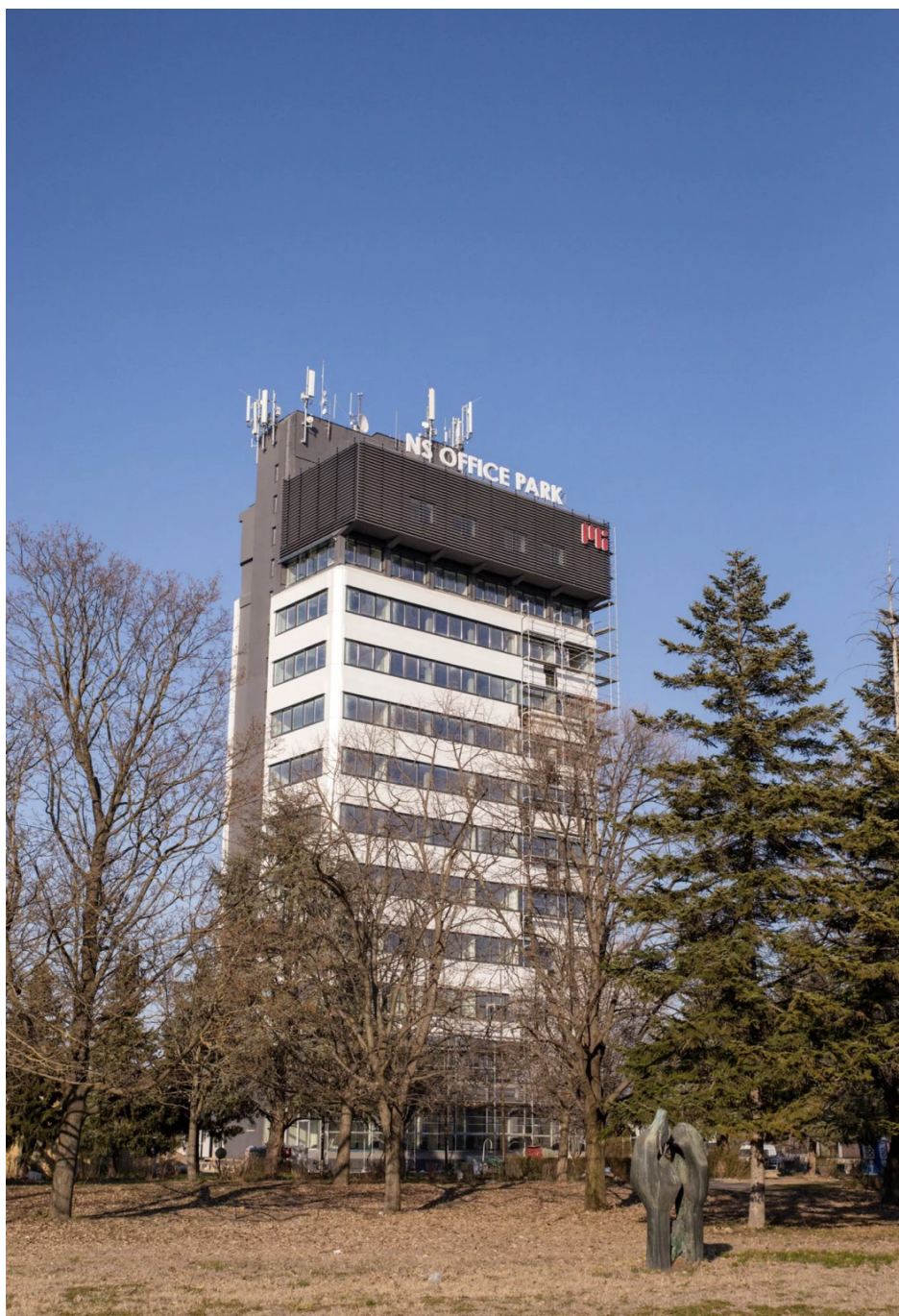
Slika br. 15 – Rekonstrukcija objekta Novkabel ERA
