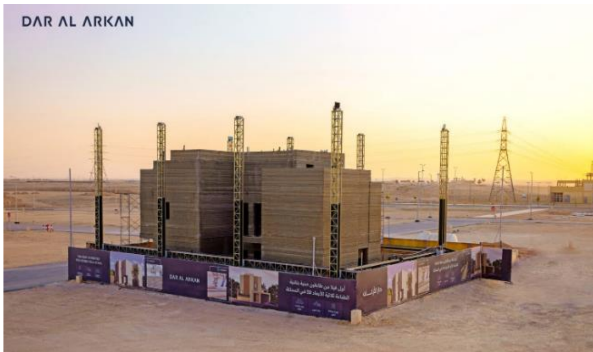
Slika br. 17: 3D štampana kuća Dar Al Arkan
