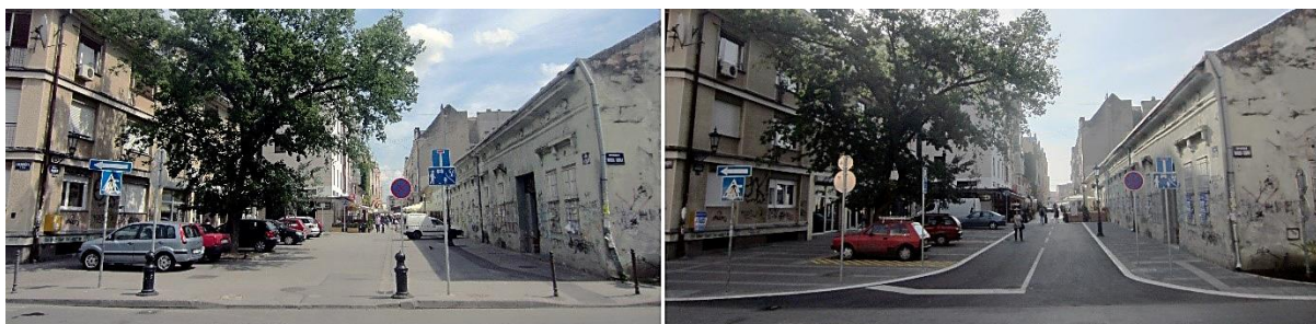
Slika 8. Rekonstrukcija Njegoševe ulice u pešačkoj zoni Novog Sada 2014. godine, iz neregulisanog parking prostora (levo), u uređen parking i pristupnu saobraćajnicu do stambenog objekta (desno)
