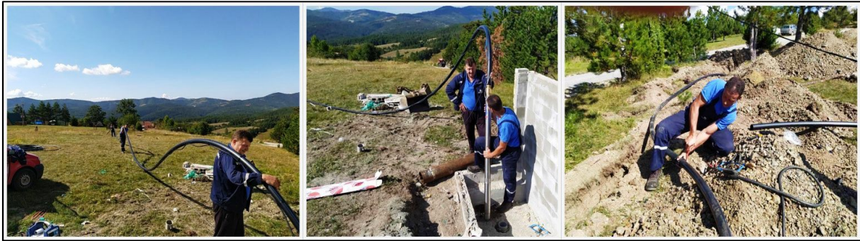
Слика 59. Изградња водоводне мреже у Горњој Шљивовици Извор: ЈКП „Водовод Златибор“ (2020)
