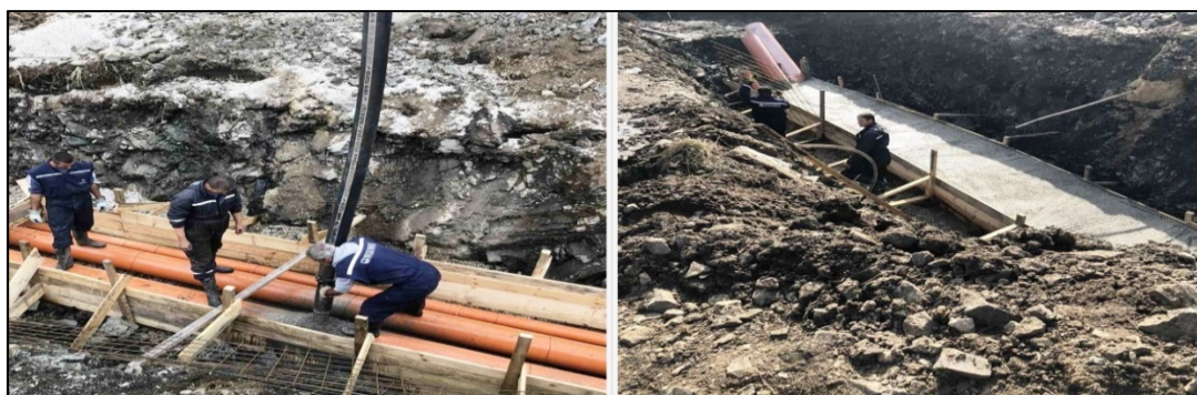
Слика 61. Изградња канализационе мреже на Златибору Извор: ЈКП „Водовод Златибор“ (2020)
