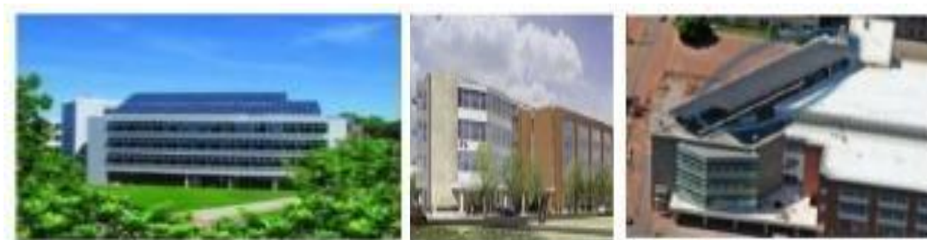
Slika. 31. Zgrada vladinih javnih službi u Kanadi
