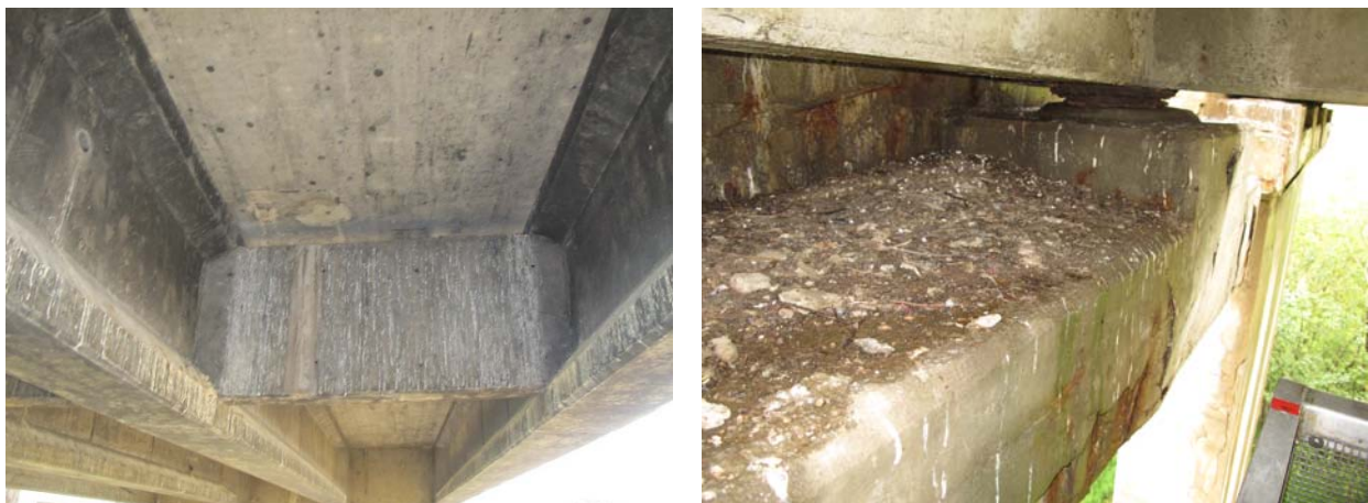
Slika 3.17 Organska jedinjenja životinjskog porekla na betonskim elementima mosta
