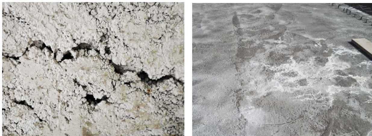
Slika 2.7 Segregacija betona
