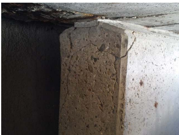
Slika 2.11 Oštećenja betona usled deformacije
