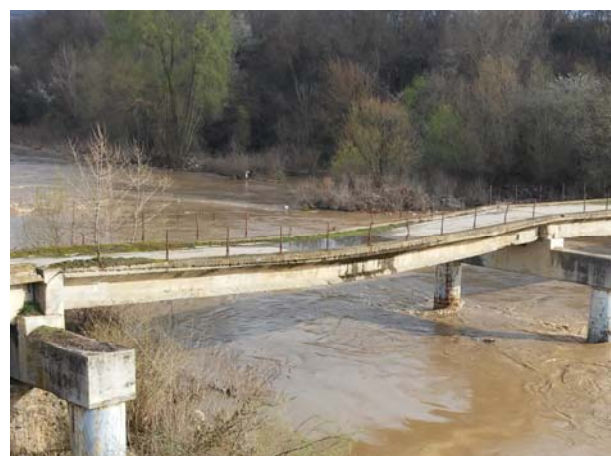
Slika 2.11 Oštećenja betona usled deformacije
