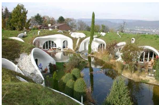
Slika 113: Podzemna kuća, Dieticon, Švajcarska 314
