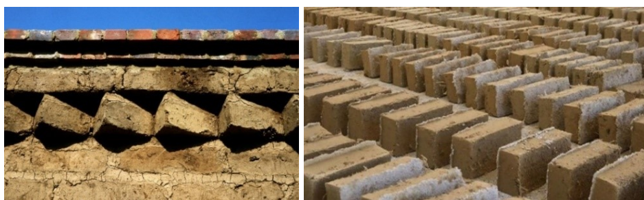
Slika 203 i 204: Oblici i izgled blokova od čerpića 413
