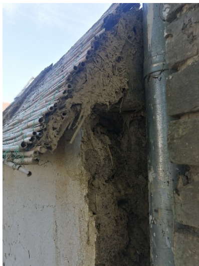
Slika 258: Detalj ogradnog zida od nabijene zemlje prekrivenog slojem uvezane trske 488
