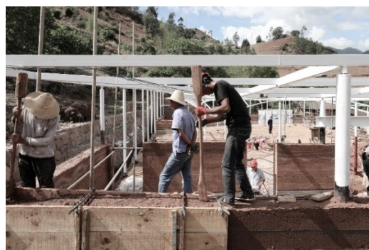
Slika 123 i 124: Lokalna tehnika izgradnje zidova od nabijene zemlje primenjena u izgradnji društvenog centra 336
