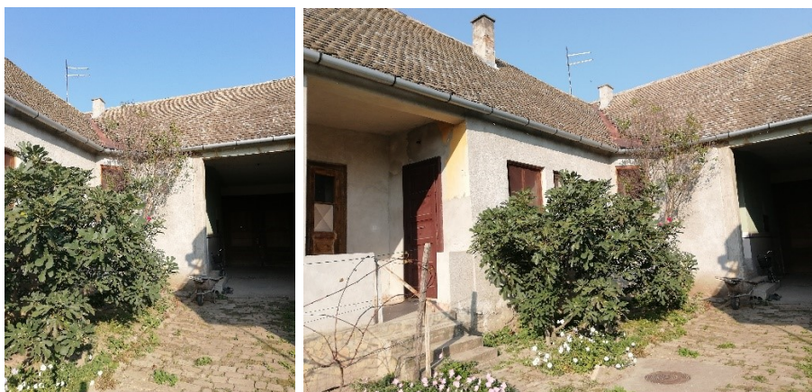
Slike 325 i 326: Izgled krovne konstrukcije kuće u Gakovu 586
