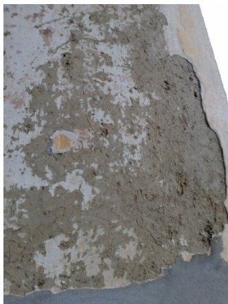
Slika 313: Detalj zida od opeke starog formata, obloženog blatnim malterom sa plevom 562
