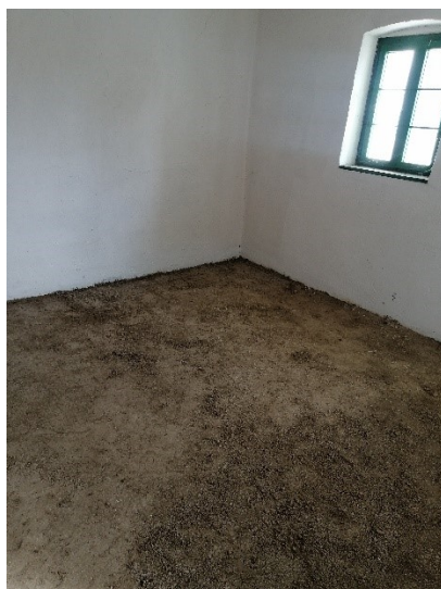
Slika 262: Pod od nabijene zemlje u kući u Ruskom Krsturu 496
