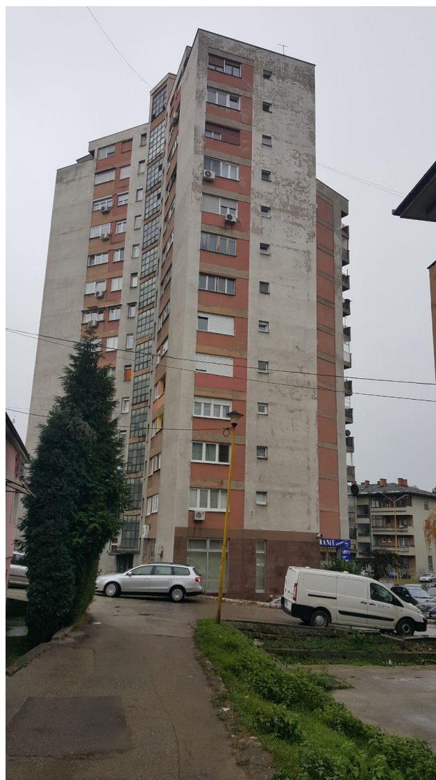
Slika 22: zgrada Zvijezda, Tuzla
