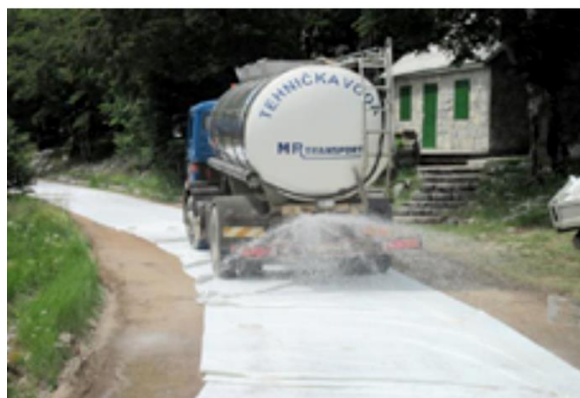
Слика 9.16. – Заштита стабилизованог слоја геотекстилом и поливање водом током периода његе
