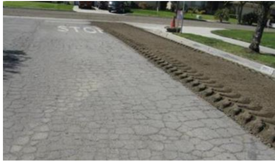
Слика 2.5. – Асфалтни застор са мрежастим пукотинама прије и након проласка рециклера [14]
