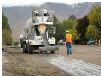
Слика 7.6. – Додатак цемента и воде у облику муља ( cement slurry ) [77]
