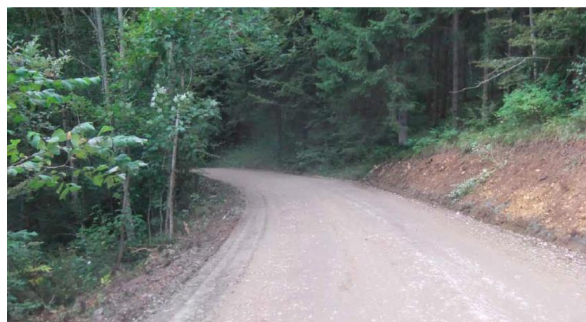
Слика 7.11. – Коловозна конструкција са површинским слојем цементне стабилизације [30]
