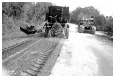
Слика 9.1. – Додатак воде рециклираном асфалту
