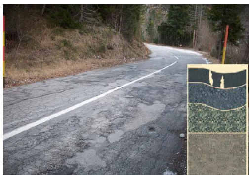
Слика 3.1. – Лоше постојеће стање комплетне коловозне конструкције пута Idrija-Idrijska Bela (Словенија) који је кандидат за хладну рециклажу асфалта [17]
