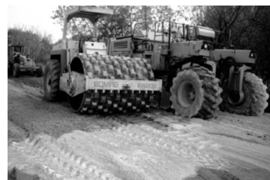
Слика 9.3. – Поступак мијешање и збијање стабилизованог слоја
