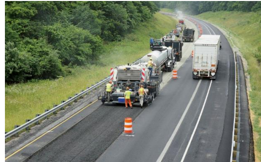
Слика 2.6. – Стругање и рециклажа постојећег асфалтног застора уз додаток цемента [13]
