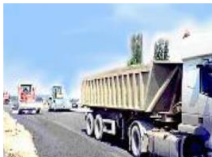
Слика 8.8. – Изградња саобраћајнице RN 47 Lens – La Bassée (Француска) уз примјену летећег пепела у градњи носивих слојева [43]
