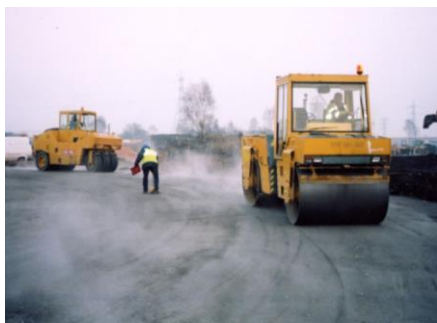
Слика 8.7. – Примјена летећег пепела при градњи саобраћајнице Burntwood Bypass (Staffordshire), Велика Британија (2001) [43]
