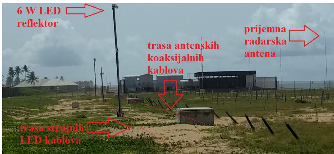
Slika 7.8 Kratkotalasni radar i LED osvetljenje u realnim uslovima na terenu
