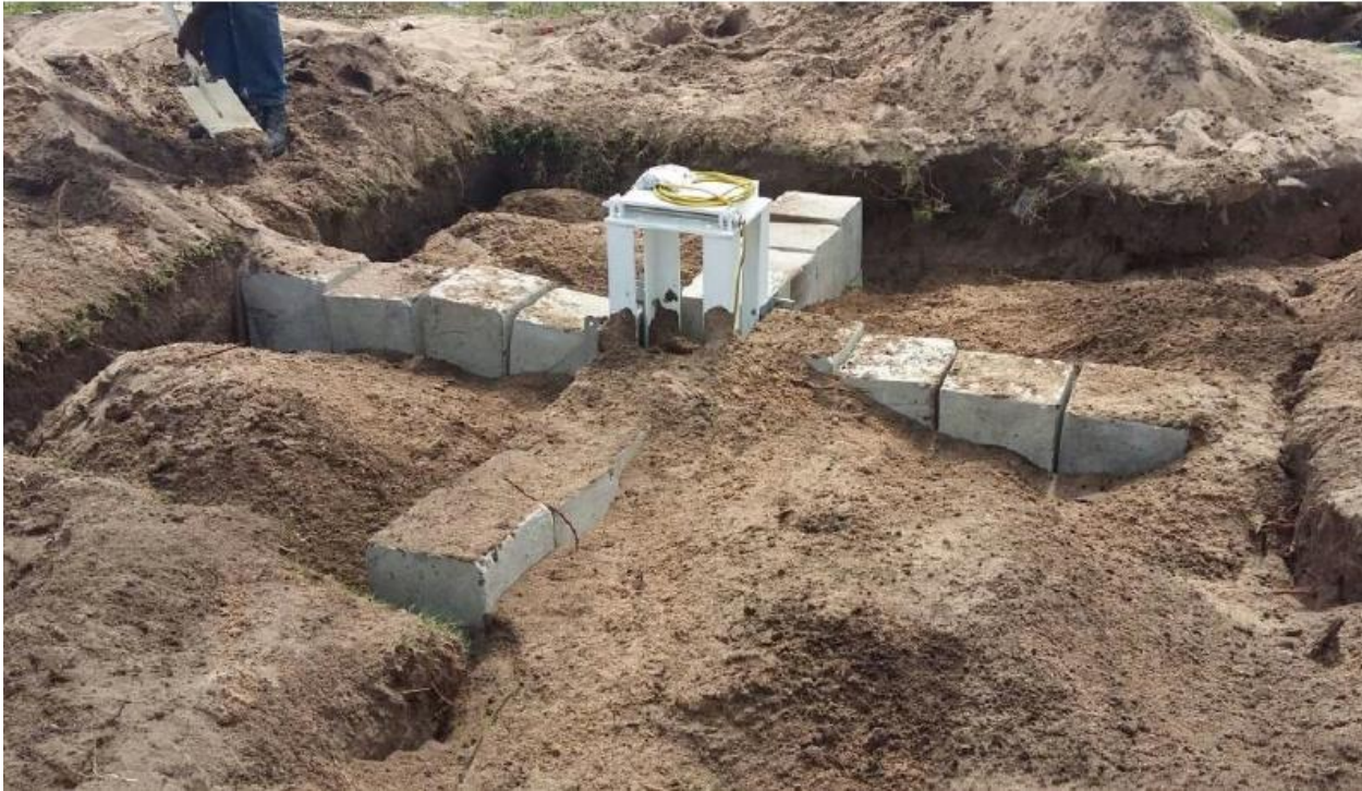
Slika 7.10 Osnova radarske antene
