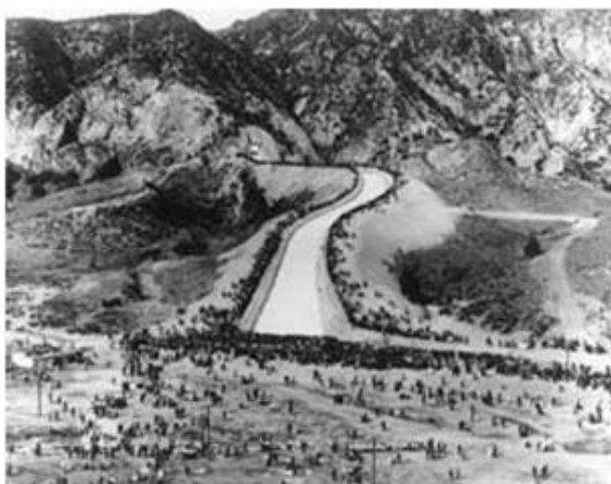
Slika II-1. Prvi akvadukt na teritoriji Los Anđelesa [67]
