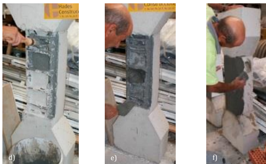
Slika V-21. Proces formiranja saniranog uzorka [130]: a) Ošalovani stub sa postavljenom armaturom, b) „Oštećen“ stub koji treba da se sanira, c) Kvašenje dela stuba koji će se sanirati u slučaju kada se direktno nanose reparaturni malteri, d) Nanošenje vezivnog sredstva, e) Nanošenje reparaturnog maltera u dva sloja i f) Zaglađivanje površine saniranog dela stuba
