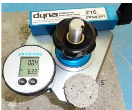
Slika VI-13. Ispitivanje čvrstoće na zatezanje neposredno pre nanošenja reparaturnog maltera na betonsku podlogu
