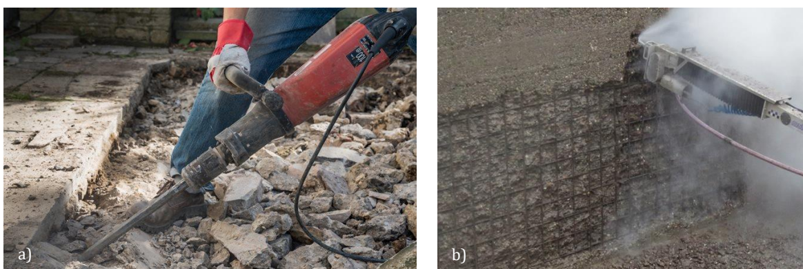
Slika IV-7. Metode za grubo uklanjanje oštećenja: a) Udarna metoda – primena pneumatskog čekića [78], b) Voda pod pritiskom [80]
