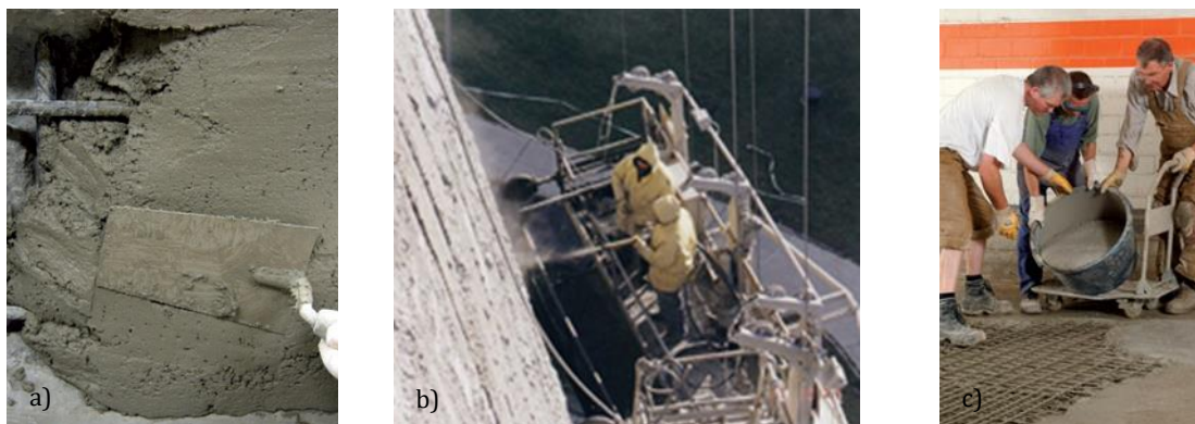
Slika IV-9. Metode nanošenja reparaturnog materijala: a) Ručno nanošenje maltera mistrijom [98], b) Prskanje betonom [79] i c) Ulivanje betona [98]
