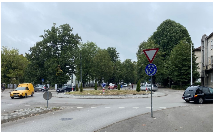
Slika 3.14 Mini kružna raskrsnica, Banjaluka (BiH), ukrštanje ulica Aleja svetog Save – Vase Pelagića
