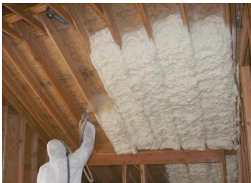
Слика 5.1.4. Наношење полиуретанске пене
