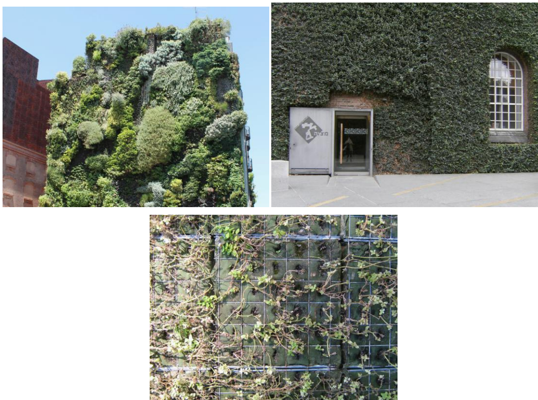
Слика 4. Зелена фасада (директна-слика горе лево) и живи зид (континуирани и модуларни- десно и доле), Извор: Manso, M. Joao, C. (2015) Green wall systems: A review of their characteristics , Renewable and Sustainable energy Reviews 41, стр. 863-871.
