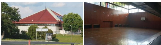
Слика 4.17. Кров- приказ зенитног осветљења на крову и главна дворана у објекту
