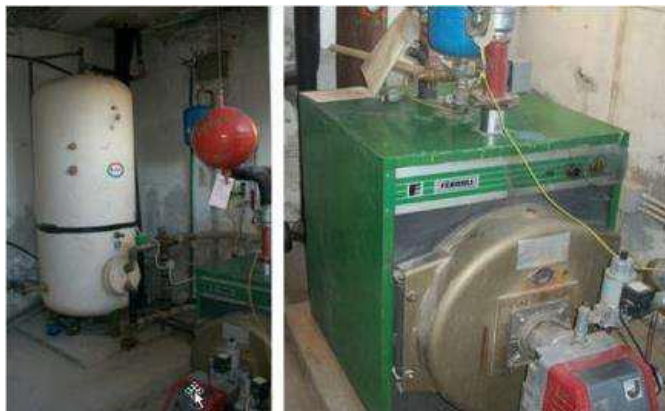
Слика 2.9. Резервоар за топлу воду и бојлер на природни гас за мањи број тушева (Fidia, Italy), Извор: SportE 2
