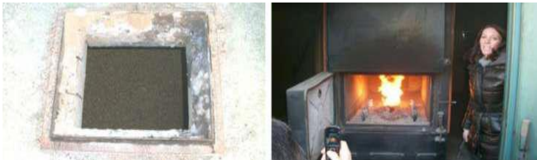
Слика 2.7. Котло на биомасу (као сировину користи љуске лешника ) у спортском центру Фидиа (Италија), Извор: SportE 2
