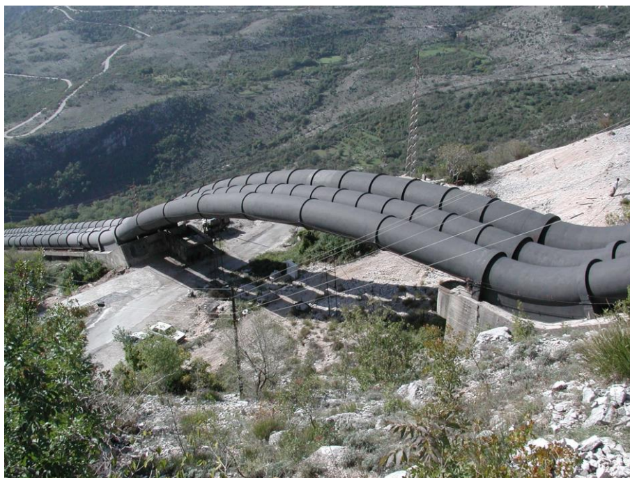
Slika 5.20: Cevovod hidroelektrane Perućica.
