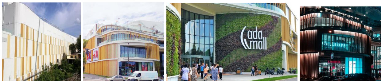
Илустрација 108. Фасада тржног центра. Извор фотографија: beobuild.rs - GTC "Ada Mall" (42)
