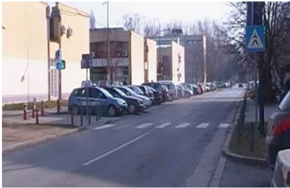
Slika 5.2 Izgled pešačkog prelaza pre rekonstrukcije
