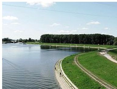
Слика 24. Канал у Новом Саду
