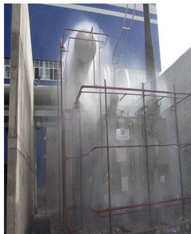
Slika 1.2. Delovanje protivpožarne zaštite transformatora [3]
