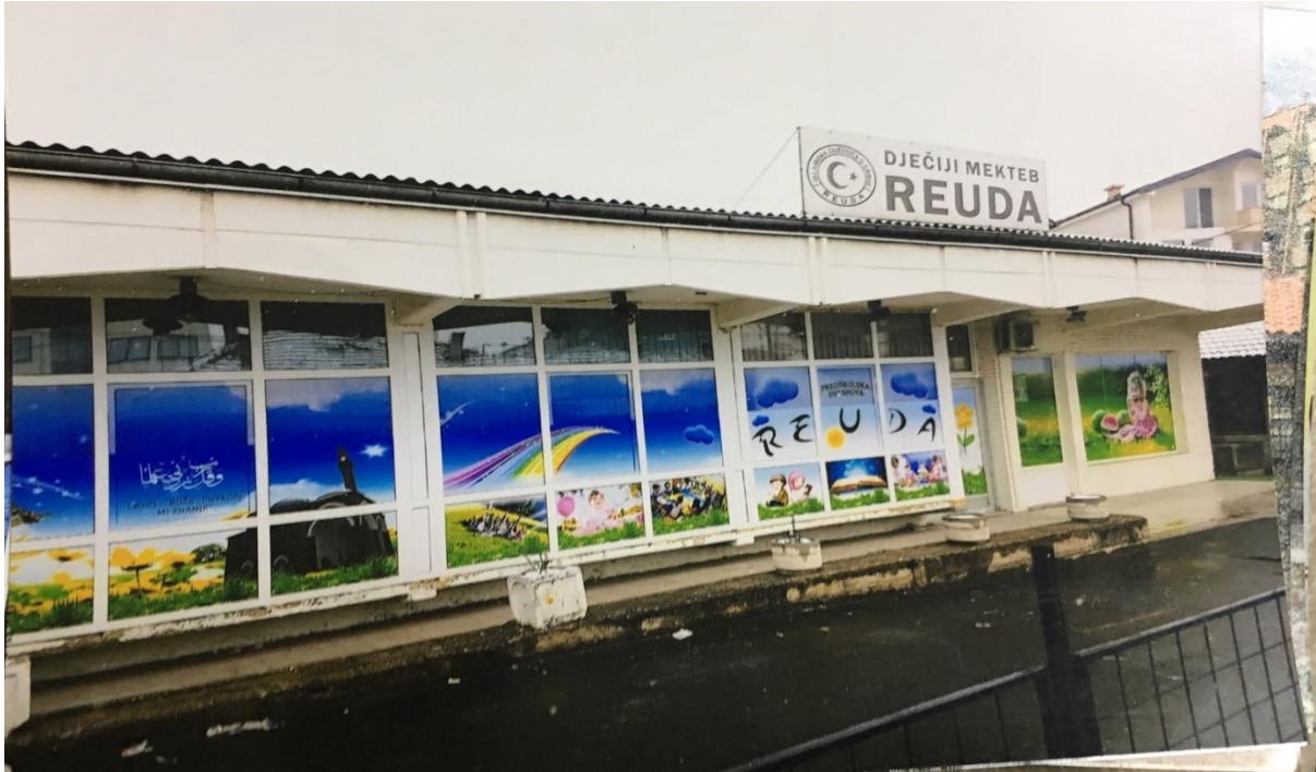
Fotografija 5. Novi objekat vrtića na Musali, smješten u prostorijama povraćenog vakufskog objekta
