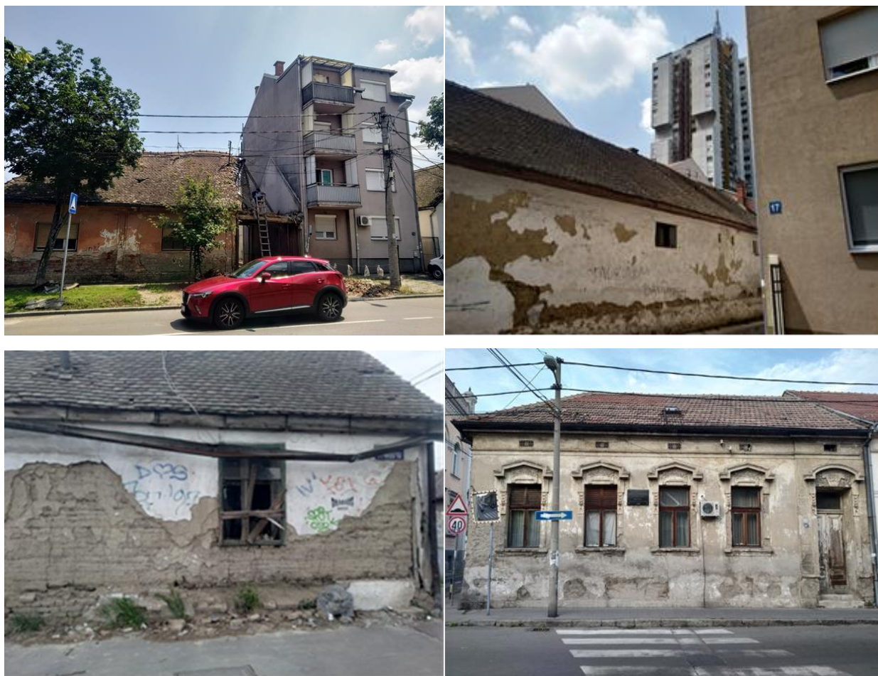
Slika 2. Socio-materijalna svojstva stanovanja. Na ovom kolažu se vide ostaci materijalnih kompozicija. Na prvoj slici je kuća iz Hecegovačke ulice, u blizini Prvomajske čiji je deo originalnog krova urušen. Pored je kuća u ulici Rade Končara, vrlo blizu prethodne i dobar prikaz kontrasta i materijalnih diskontinuiteta, gde njena ogoljena fasada otkriva originalno korišćen čerpić i zemlju. Slično je i na slici dole levo. Napuštena kuća u Ugrinovačkoj ulici, očigledno nije nikada bila adaptirana. Desno od nje se pak nalazi tip gradske kuće iz Starog jezgra, izgrađene 1928. godine.
