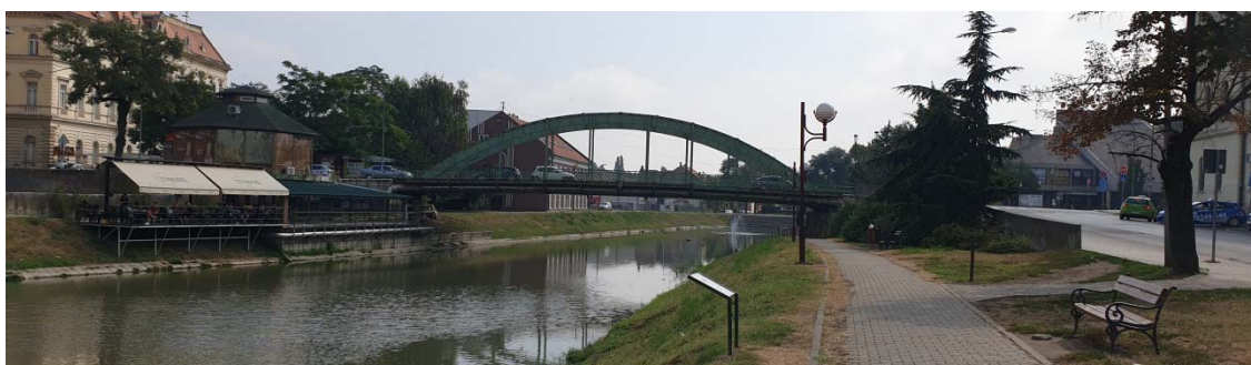
Slika _ 161 _ Mali most
