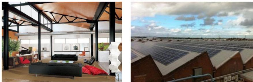
Slika 52. Integracije navojnih krovova sa solarnim panelima
