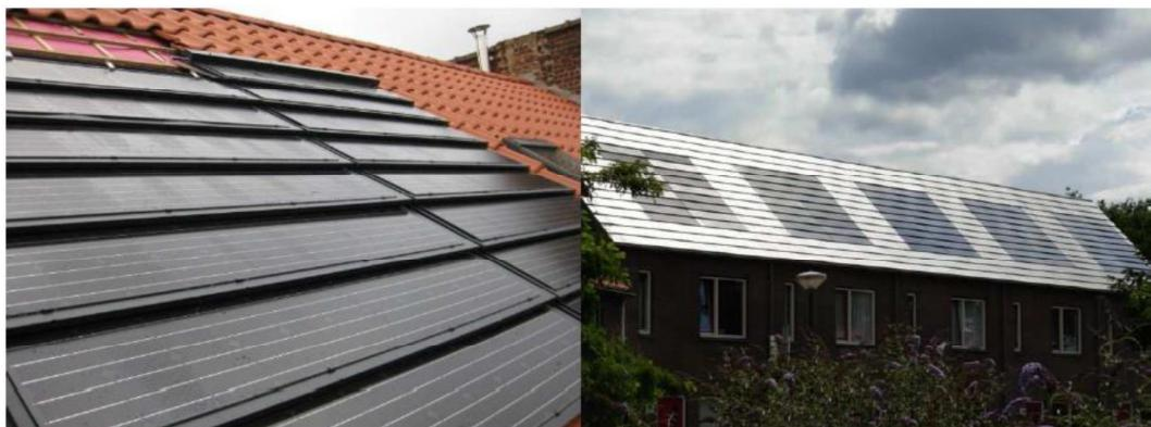
Slika 57. Solarne čelije kao alternativa tradicionalnim završnim materijalima u kosim ojačanim modulima
