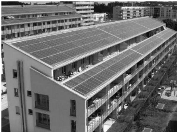
**Slika 26.** Solarni kolektori.
