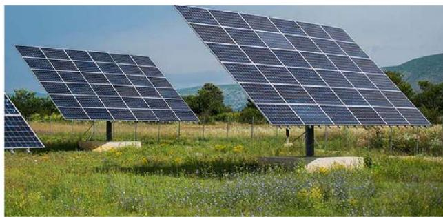
*Slika 13. Solarna elektrana Hodovo 1 u okolini Stoca firme Toming instalirane snage 148 KW i ostvarene proizvodnje 257 MWh u 2014. godine*
