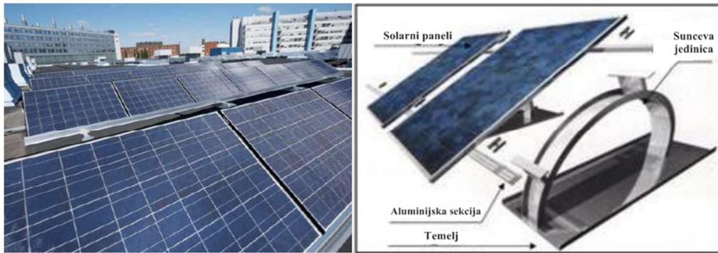
Slika 50. Kosi solarni moduli dizajnirani za horizontalne krovove.
