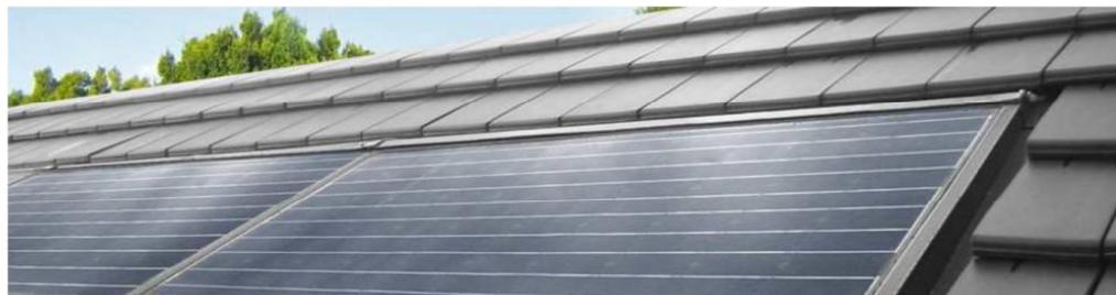
Slika 54. Primena solarne ćelije kao alternative tradicionalnog građevinskog materijala na kosim krovovima.
