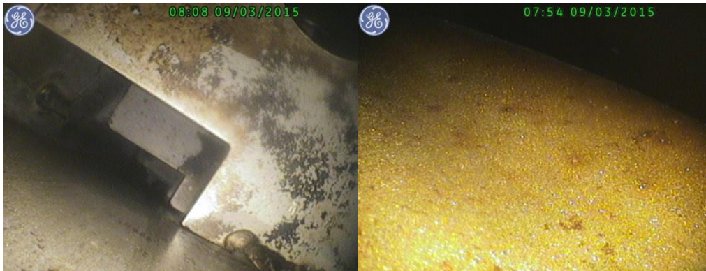
Слика 5.1. Унутрашњост резервоара горива тенка М-84
