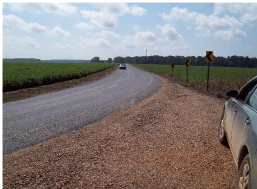
Слика 23: Крупан шљунак у функцији заустављања возила у кривини (Извор: Интернет 5)
