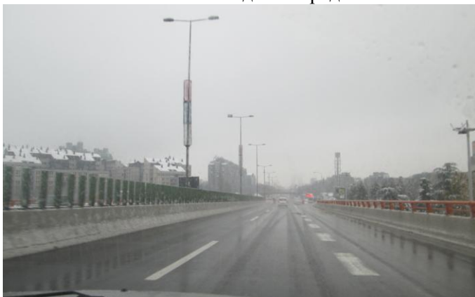
в. решеткасте заштитне ограде на мосту Газела, Београд (линија лево)
