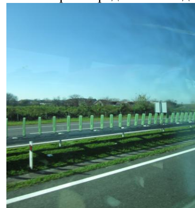
г. решеткасте заштитне ограде са одводом за воду у основи, аутопут кроз Хрватску
