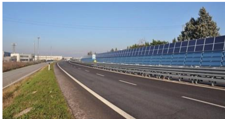
Слика 19: Заштитне ограде са фото-панелима на италијанском А-22 аутопуту (Извор: Интернет 4)
