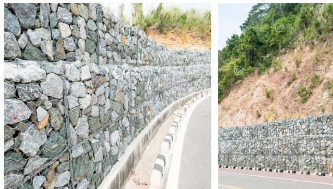
Слика 24: Заштита од ерозије - зидови од камења (Извор: Интернет 6)
