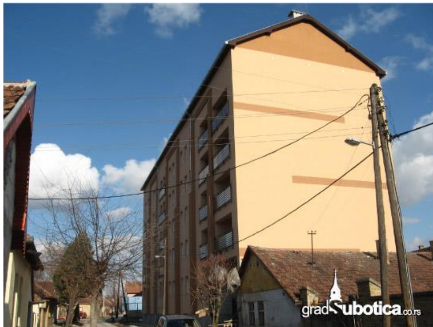
Слика 54: Објекат изграђен на подручју предметног ПДР-а.
