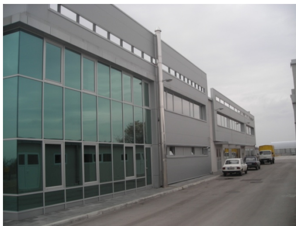
(b) Severoistočna fasada FBB zgrade
