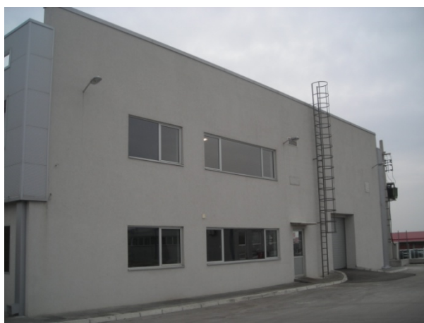
(d) Severozapadna fasada FBB zgrade
