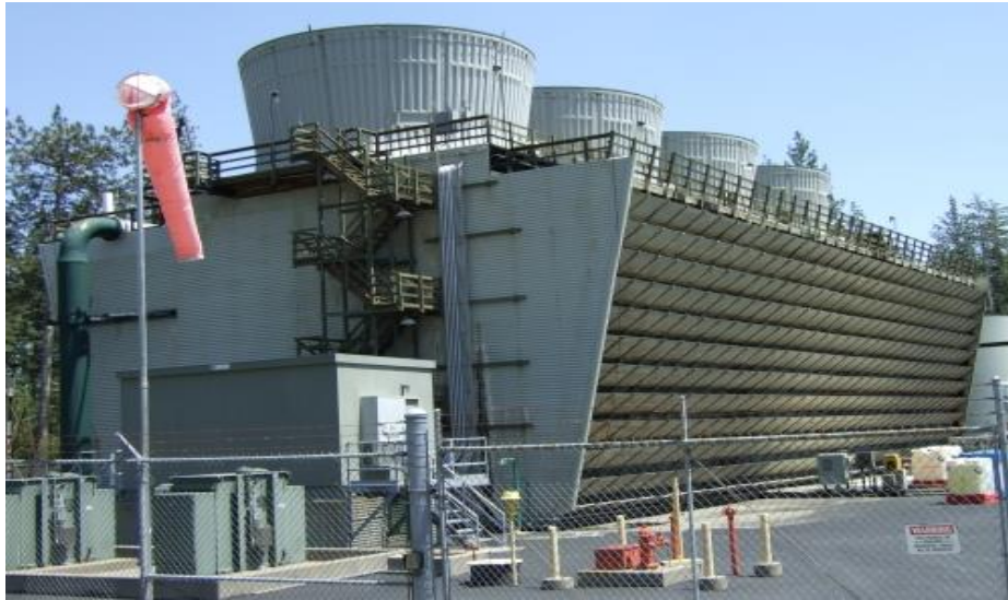
Slika 5. Geotermalna elektrana Geysers - Kalifornija, USA
