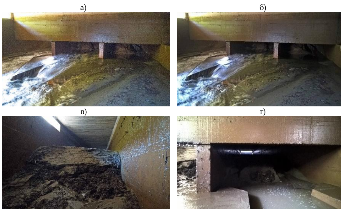
Слика 5.3 | Фотографија настала приликом чишћења таложника.
