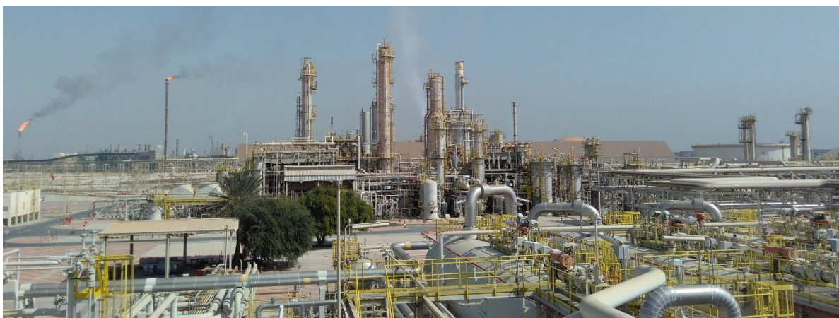
Slika 33. Izgled postrojenja za preradu, pripremu i transport gasa
