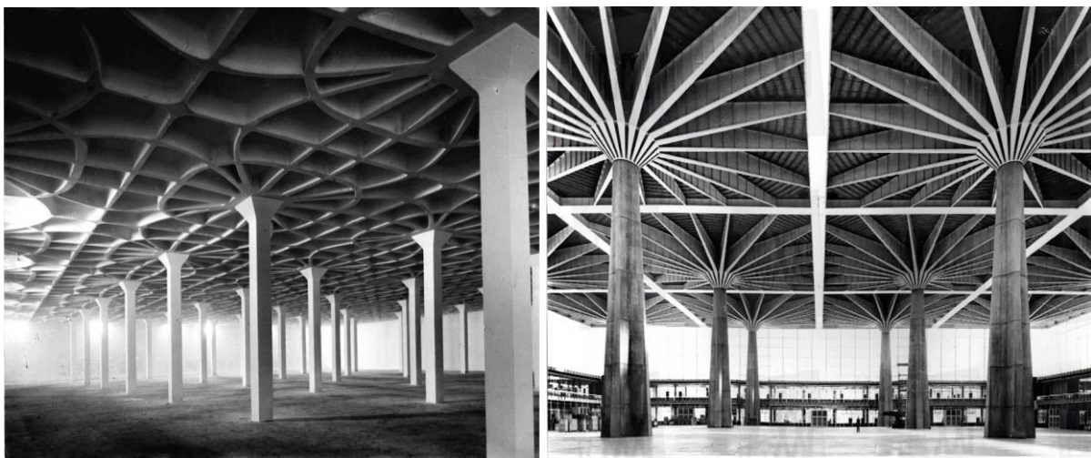
Slika 19. Pjer Luiđi Nervi, stubovi i tavanica objekta Gatti Wool Mill (Rim, 1951) i Palazzo del Lavoro (Turin, 1961)
