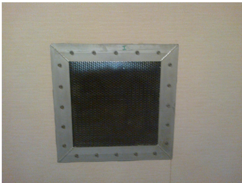
Slika 3.3 Ventilacioni otvor na zidu Faradejevog kaveza
