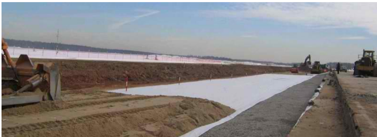
Слика 2. Геотекстил при уградњи [22]
