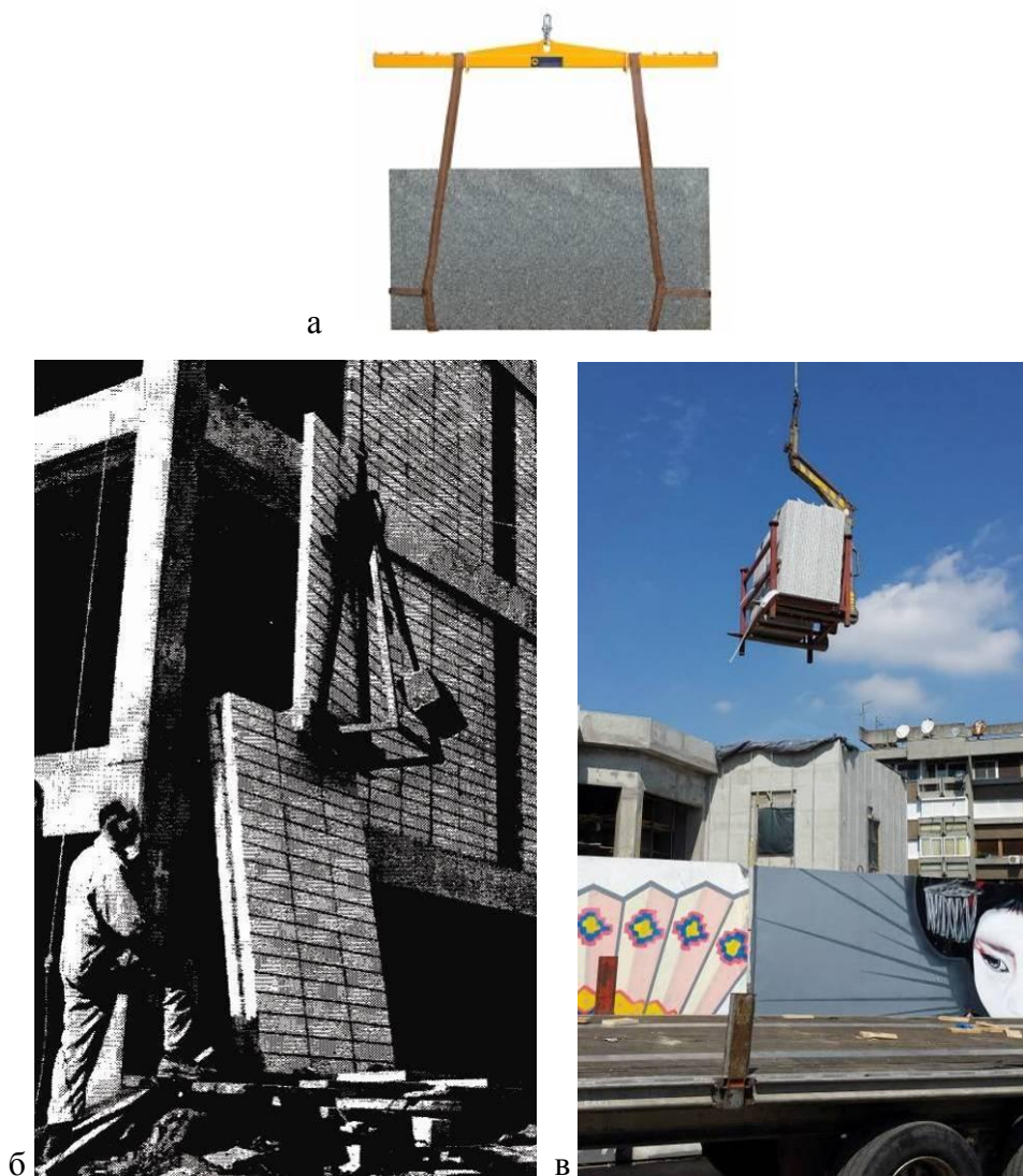
Слика 99 Захват фасадног панела а) каишевима (Abaco), б) појединачно А рамом (Svec & Jeffers, 1972), в) у групи, учвршћених вертикално (Tabaš)
