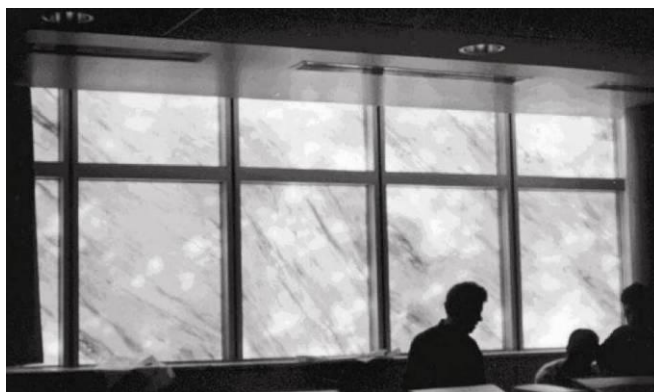
Слика 27 Композитни панел са подлогом од стакла: а) панел произвођача TerraCore (TerraCore Panels), б) панел са лицем од мермера у систему зид-завесе E.N.S.A.D. - Ecole Nationale Supérieure des Arts Décoratifs , Париз (Loughran, 2006)
