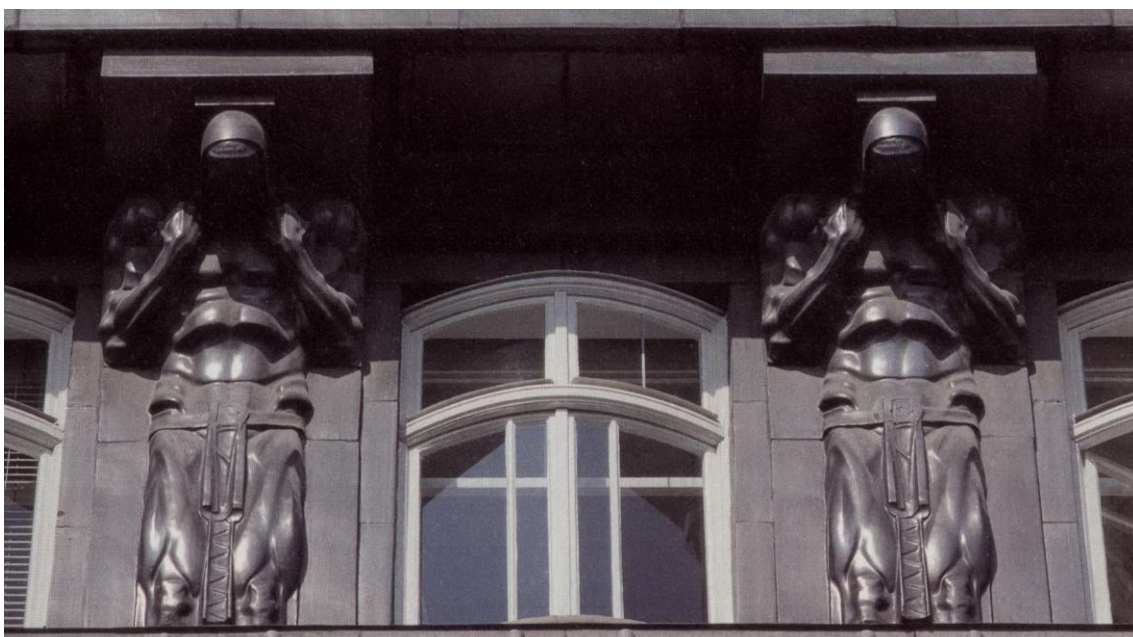
Franc Mecner, Atlasi sa krovnog venca na zgradi Caherhaus (arhitekta Jože Plečnik), 1905, Beč
