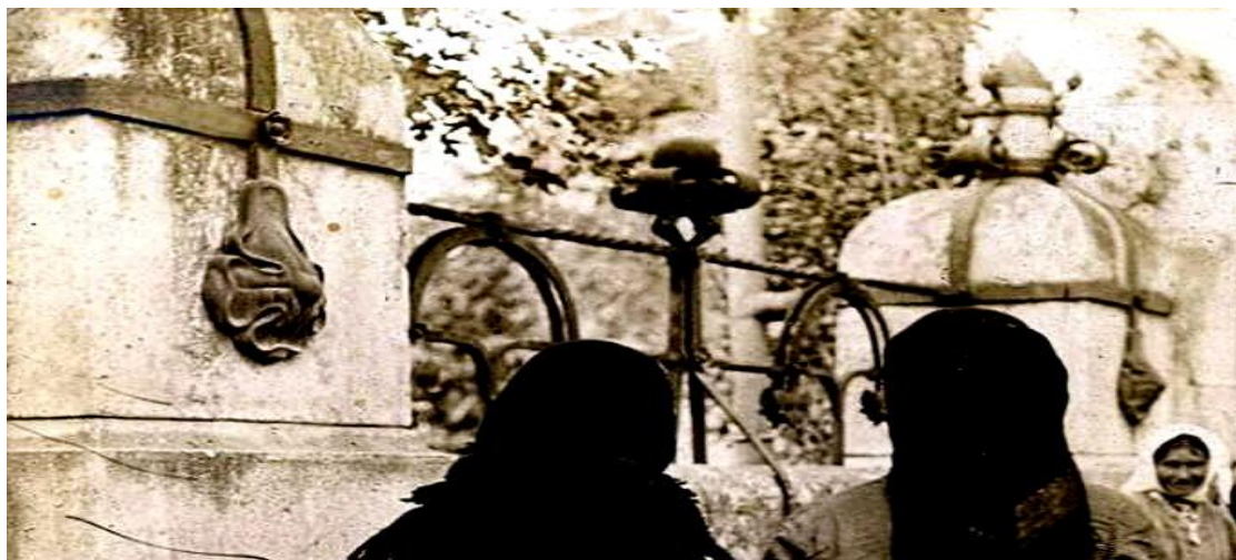
Motiv kovine sa betonske ograde u Nišu, početak 20. veka, lokacija nepoznata
