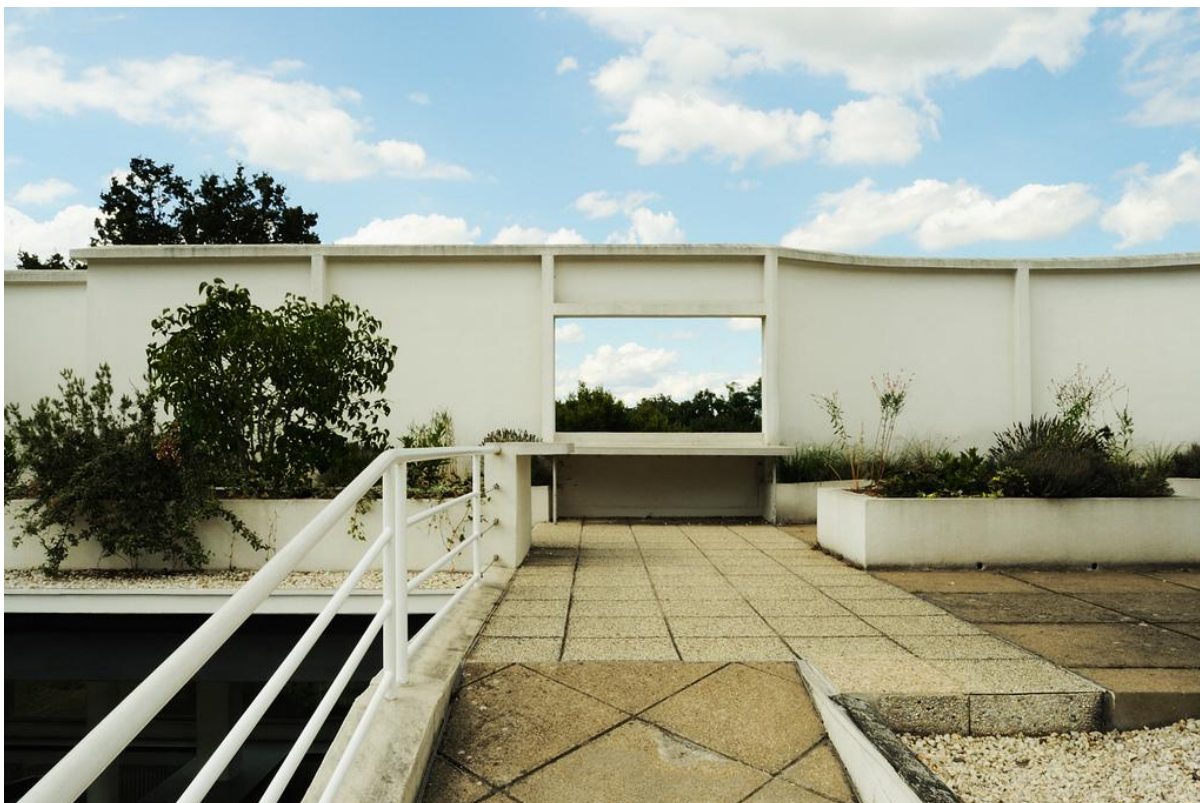
Сл. 4а. Ле Корбизје, Вила Савој , Поаси: детаљ кровне баште (1929–31).
