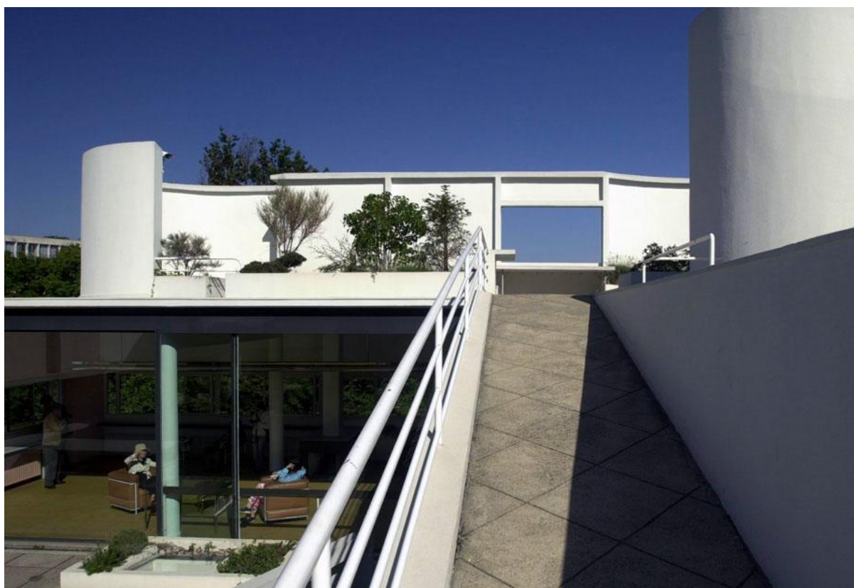
Сл. 4. Ле Корбизје, Вила Савој , Поаси: детаљ кровне баште (1929–31).
