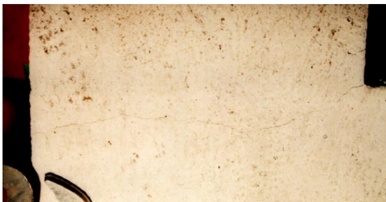
Слика 9.6. Приказ пукотине у десном углу носеће структуре
