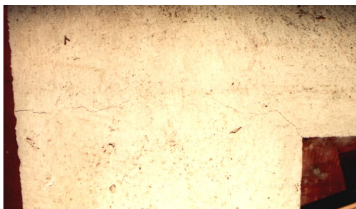
Слика 9.5. Приказ пукотине у левом углу носеће структуре
