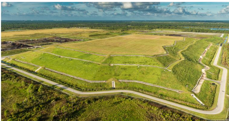
Slika 1.1: Primer propisno zatvorene deponije komunalnog otpada ( www.waste360.com )
