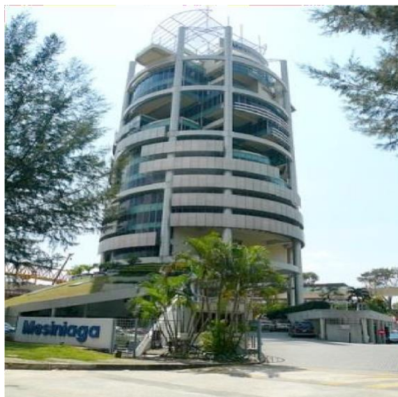
Slika 33. Projekat Messinaga Tower (Kuala Lumpur –Malezija)
