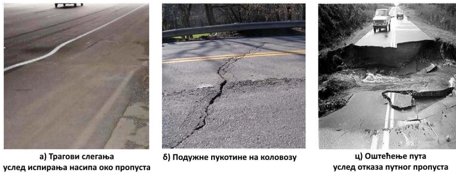
Слика 1-9: Примери оштећења пута пре а-б) и после отказа пропуста ц) [25]
