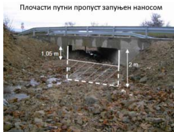
Слика 1-13: Плочасти пропуст запуњен наносом [45]
