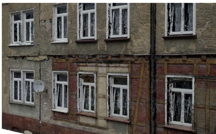
Sl. 3.14 – Oblak tačaka fasade zgrade generisan obradom slika prikupljenih dronom (Banaszek et al., 2017)
