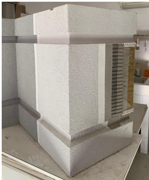
Sl. 5.87 – Model realnih razmera sistema kontaktne fasade sa prikazom mogućnosti izrade kanelura (Knauf Insulation)
