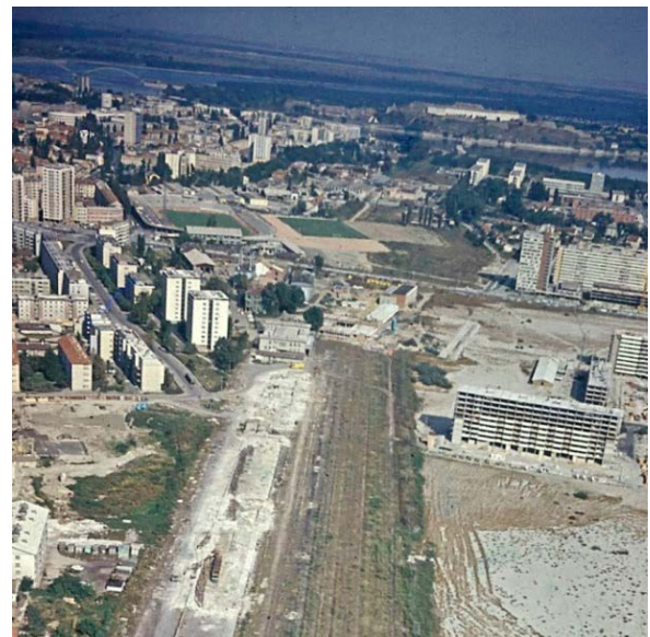
Sl. 2.5 – Grbavica (levo), izgradnja Limana 3 (desno), 1970. godina (Stare fotografije Novog Sada)
