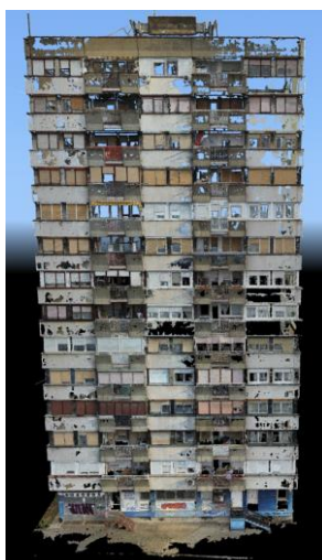
Sl. 5.8 – Jugozapadna fasada: digitalna fotografija, oblak tačaka (sa preko 25 miliona tačaka) i ortofasada (sa prosečnom rezolucijom od 2,3 mm)
