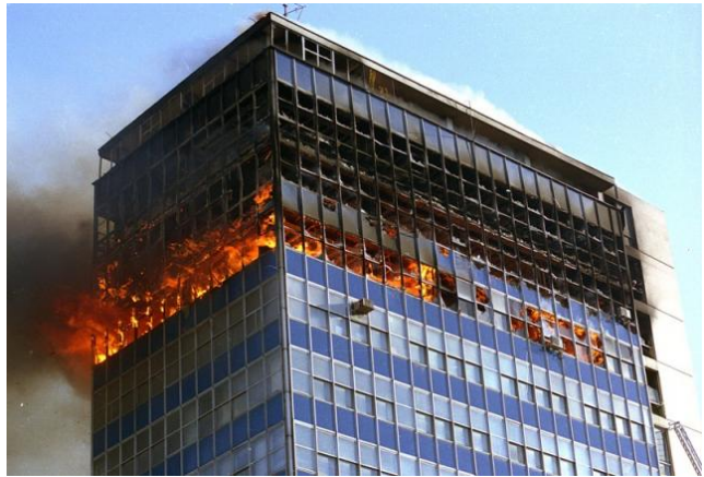
Sl. 3.39 – Otvoreni univerzitet u Novom Sadu u požaru (Vujačić, 2017)
