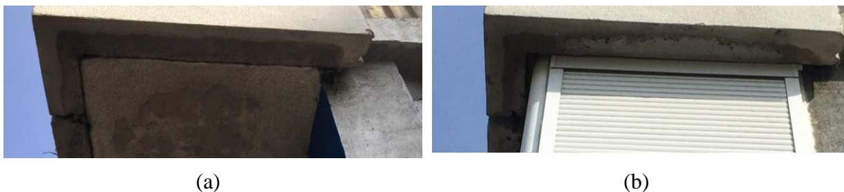
Sl. 5.39 – Mrlje od prodora atmosferilija kroz spojnice: (a) parapet P_{A-B/1,I} i (b) parapet P_{A-B/1,II}
