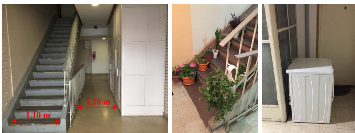
Sl. 5.76 – Evakuacioni putevi: (a) nedovoljna širina glavnog stepeništa i hodnika; (b) prepreke u vidu saksijskog cveća; (c) prepreke u vidu nameštaja;
