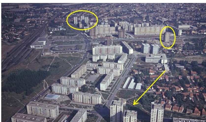
Sl. 4.4 – Stambene kule u okolini železničke stanice autora arh. Petra Jankova (početak 70-ih): kule u ulici Kraljevića Marka (gore), na Bulevaru Oslobođenja (desno) i u ulici Pariske komune (dole) 1 (Stare fotografije Novog Sada)
