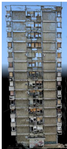
Sl. 5.9 – Severozapadna fasada: digitalna fotografija, oblak tačaka (sa preko 18 miliona tačaka) i ortofasada (sa prosečnom rezolucijom od 2,8 mm)
