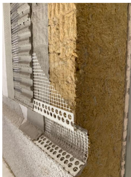
Sl. 5.87 – Model realnih razmera sistema kontaktne fasade sa prikazom mogućnosti izrade kanelura (Knauf Insulation)
