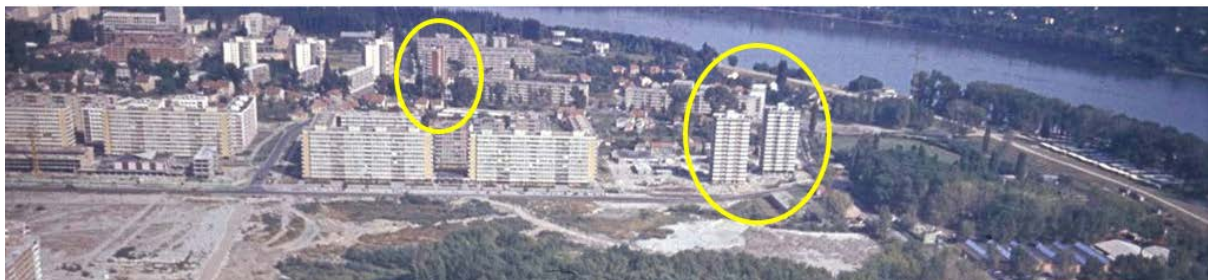
Sl. 4.5 – Kule na Limanu 1 i 2 1970. godine: levo - kula P+13 u Fruškogorskoj ulici; desno - kule S+P+14 kod današnjeg Mosta Slobode – dve kule su izgrađene, treća je u fazi izgradnje (Stare fotografije Novog Sada)
