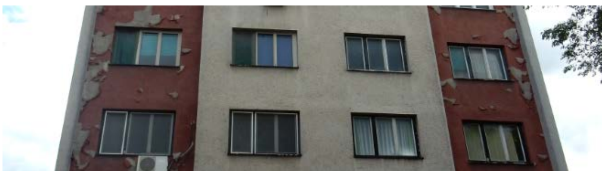
Sl. 4.19 – Detalji fasade stambene kule Fu-37: spoljni zidovi od opeke d=25\text{ cm} , sa završnom oblogom od plemenitog maltera („teranova“)
