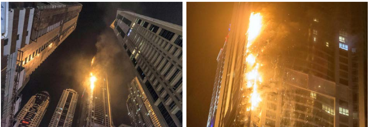
Sl. 3.34 – Torch kula u Dubajju u požaru 2017. godine: širenje požara putem gorivog fasadnog sistema (Webster & Langton, 2017)
