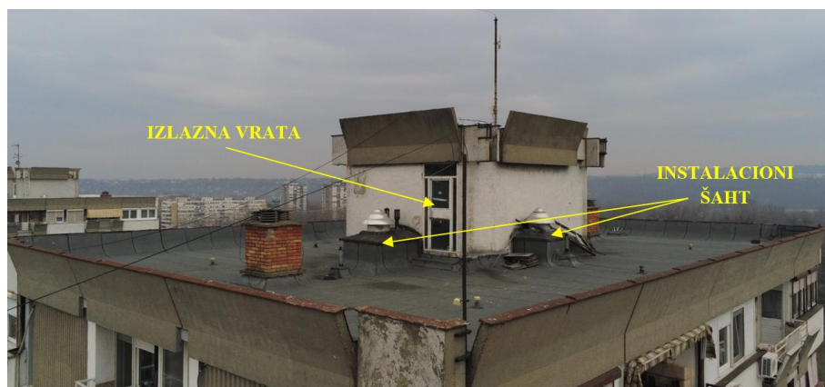
Sl. 5.83 – Izlazna vrata koja vode na ravan krov i instalacioni šahtovi
