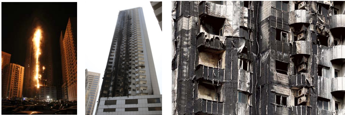
Sl. 3.35 – Zgrada „Al Tayer“ u gradu Šardža u Dubajiu u požaru i nakon požara 2012. god. koji se širio putem gorive fasade (Emirates 24/7, 2012a; 2012b; Baldwin & Leon, 2012)
