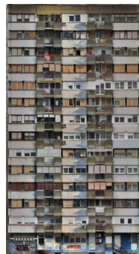
Sl. 5.8 – Jugozapadna fasada: digitalna fotografija, oblak tačaka (sa preko 25 miliona tačaka) i ortofasada (sa prosečnom rezolucijom od 2,3 mm)
