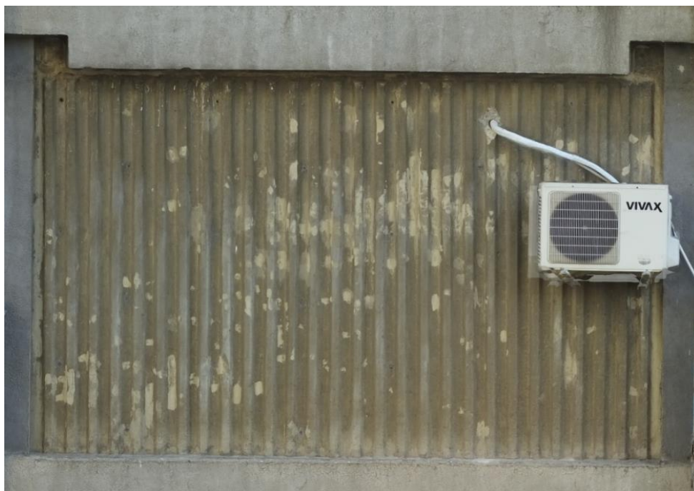
Sl. 5.18 – Promene boje zidova na severnoj fasadi (segment zida Z D-E/6 na II spratu)
