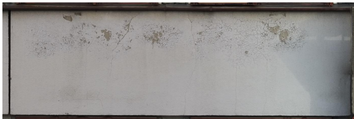
Sl. 5.35 – Ljuškanje i odvajanje završnog dekorativnog maltera u gornjim zonama parapetnih elementa dužih fasada (parapet P_{5-6/A,VIII} )
