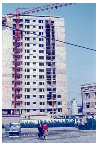
Sl. 4.3 – Kula kod stadiona u izgradnji 1963. godine (Stare fotografije Novog Sada)
