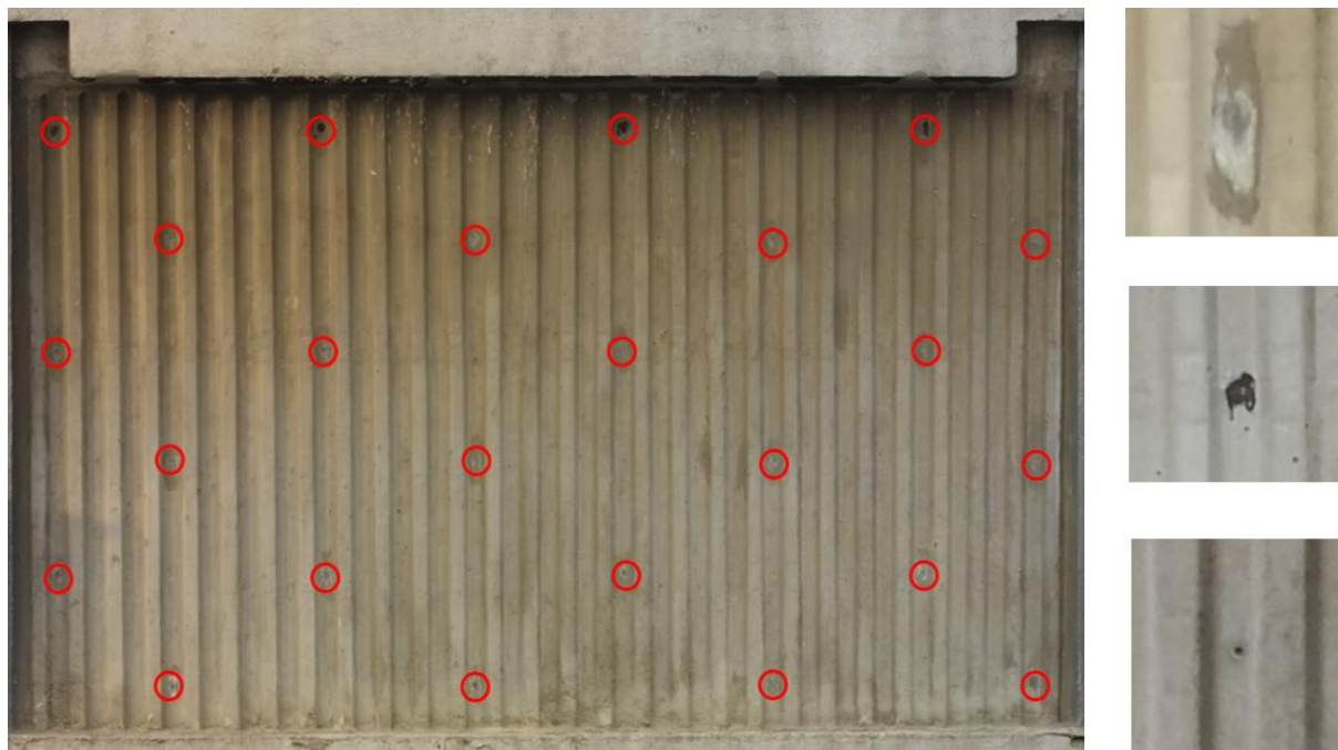
Sl. 5.24 – Tragovi pričvršćivanja oplatnih ravni identifikovani na AB zidovima
