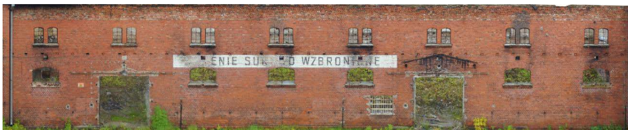
Sl. 3.13 - Ortomozaik fasade kreiran na osnovu fotografija drona (Banaszek et al., 2017)
