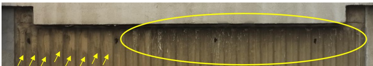
Sl. 5.17 – Lokalne promene boje zidova neposredno ispod ivičnog nosača (segment zida Z B-C/1 na VIII spratu)
