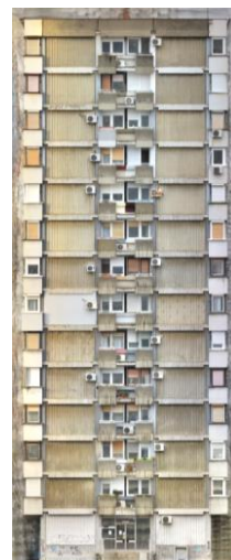
Sl. 5.7 – Jugoistočna fasada: digitalna fotografija, oblak tačaka (sa preko 35 miliona tačaka) i ortofasada (sa prosečnom rezolucijom od 2,2 mm)
