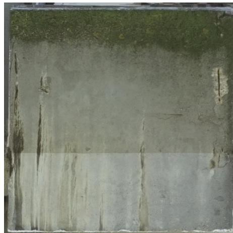
Sl. 5.41 – Oštećenja identifikovana na montažnim AB ogradama: mali zaštitni sloj betona, pucanje, odvajanje i otpadanje betona usled korozije armature, mrlje od slivanja kiše, biološka korozija lokalno nedovoljno zbijen beton
