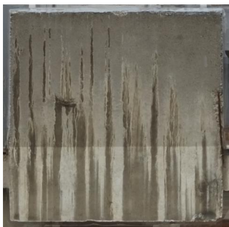
Sl. 5.41 – Oštećenja identifikovana na montažnim AB ogradama: mali zaštitni sloj betona, pucanje, odvajanje i otpadanje betona usled korozije armature, mrlje od slivanja kiše, biološka korozija lokalno nedovoljno zbijen beton
