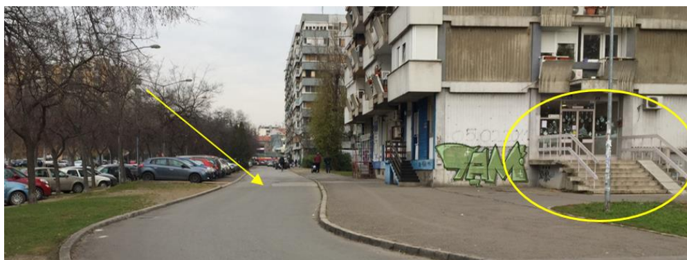
Sl. 5.2 – Kolovoz uz zapadnu fasadu zgrade i spoljno pristupno stepenište na južnoj fasadi
