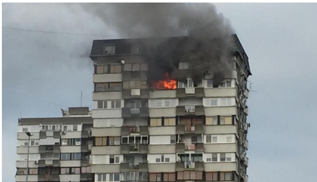
Sl. 5.71 – Požar na visokoj slobodnostojećoj stambenoj zgradi BO-155 ( S+P+14+Pk) na Limanu II: požar je izbio na 13. spratu i putem fasade se proširio na 14. sprat i potkrovlje i krov (Portal 021, 2020)
