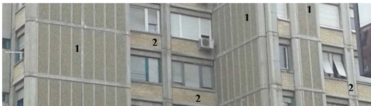
Sl. 4.52 – Detalji fasade stambene kule BO-28: puni zidni montažni paneli sa osnovnim slojem od kermazit betona i oblogom od kulije betona (1) i klasično zidani parapeti od gasbetonskih blokova, sa završnom oblogom od fasadne šuplje opeke (2)
