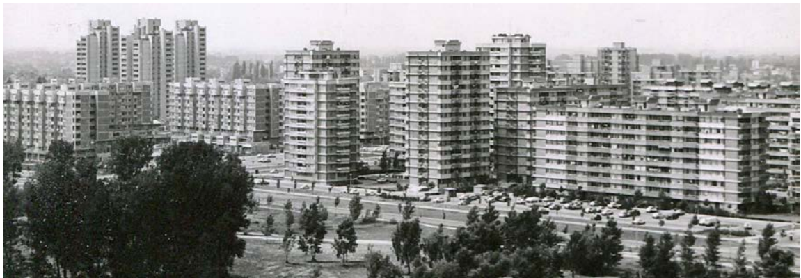
Sl. 4.10 – Visoke stambene zgrade na Limanu 3 – levo tri kule na uglu Bulevara cara Lazara i Balzakove, desno kule na uglu Narodnog fronta i Šekspirove (Stare fotografije Novog Sada)
