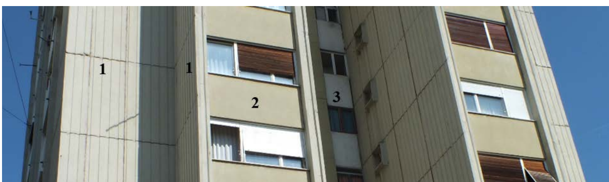
Sl. 4.25 – Detalji kraće fasade stambene kule Fr-6: montažna AB viseća kanelirana platna (1), montažne parapetne obloge (2) i montažni parapetni elementi na spoljnim ostavama (3)
