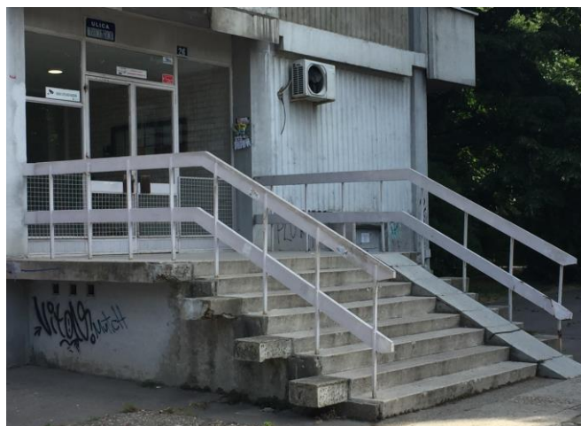
Sl. 5.75 – Pristupno stepenište i rampa
